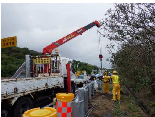
ガードレール取替
