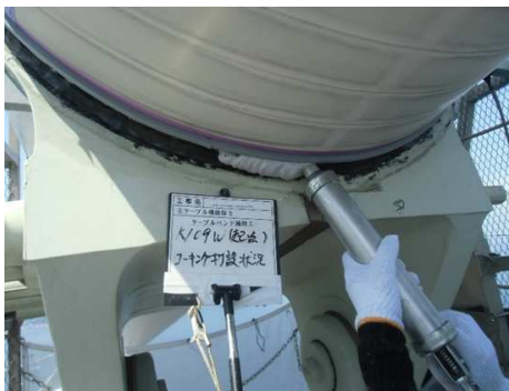
ケーブルバンドシール補修状況 (一般国道 28 号 明石海峡大橋)
