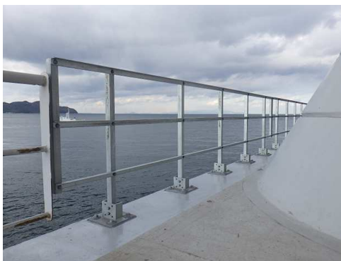
管理路(手摺り)補修 (一般国道 28 号 大鳴門橋)
