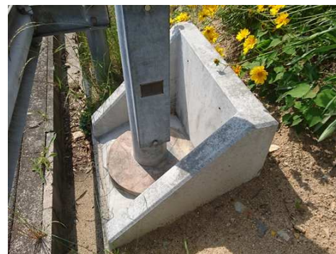
照明柱基部 (補修後)
