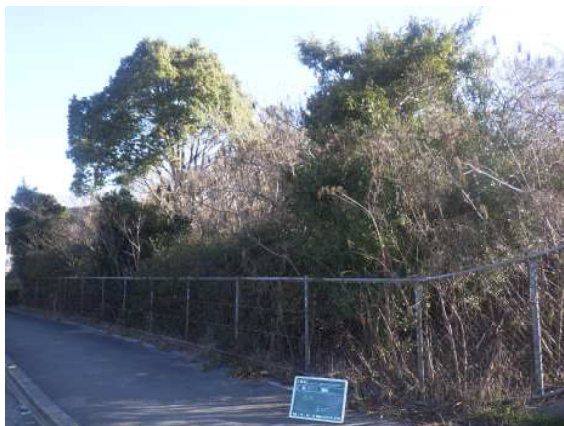
沿道環境整備(伐採) 作業前
