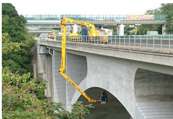
点検状況（土木）
