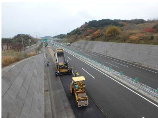
舗装補修工事
