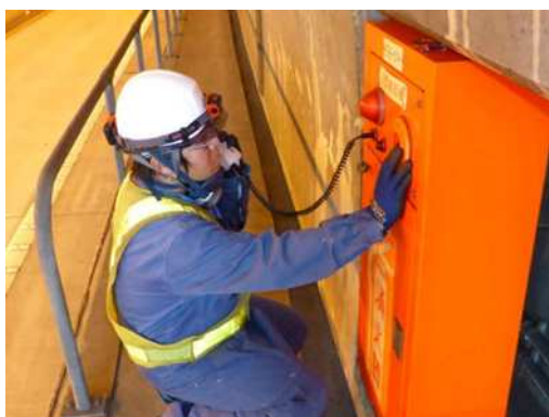
点検状況（機械設備）
