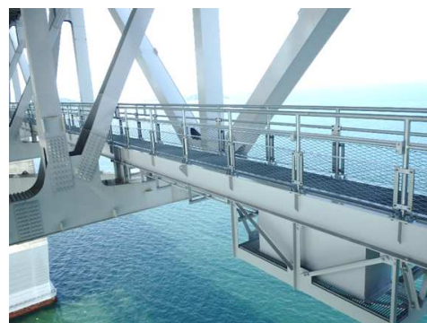
管理路補修 (一般国道 30 号 瀬戸大橋)
