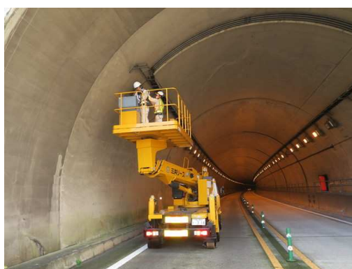
緊急点検実施状況
