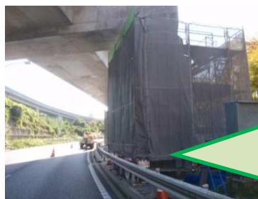
コンクリート橋脚の補強(垂水 IC I ランプ橋)
