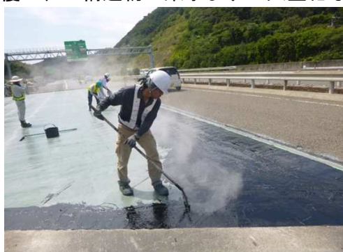
高性能床版防水工施工状況
