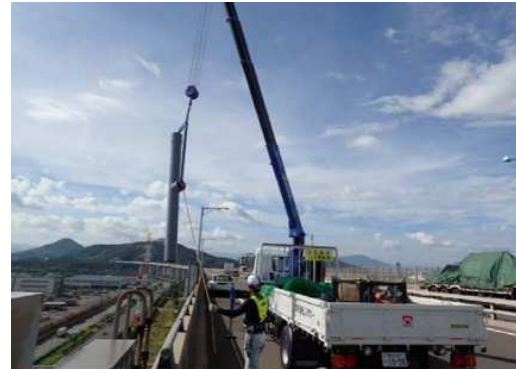
瀬戸大橋橋梁附属物交換
