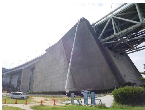
点検状況（長大橋）
