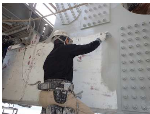
塗替塗装状況 一般国道 30 号 瀬戸大橋
