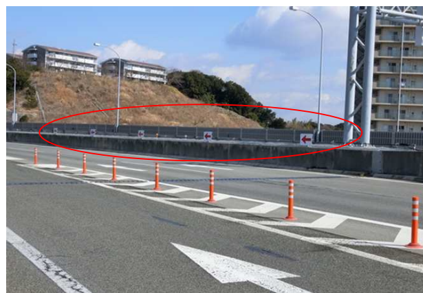
高輝度矢印板の設置
