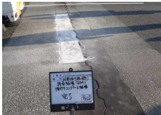
伸縮装置後打ちコンクリート(補修後)
