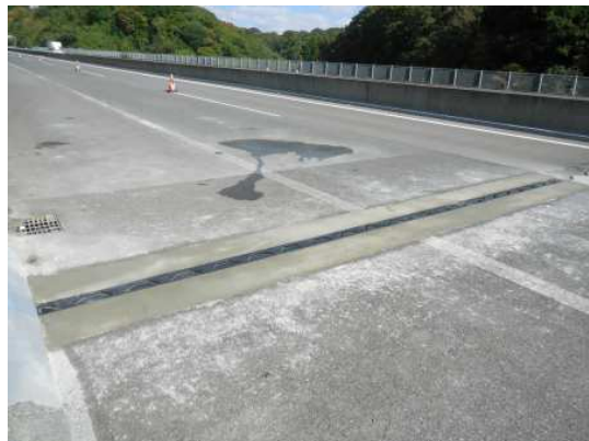
伸縮装置補修工事
