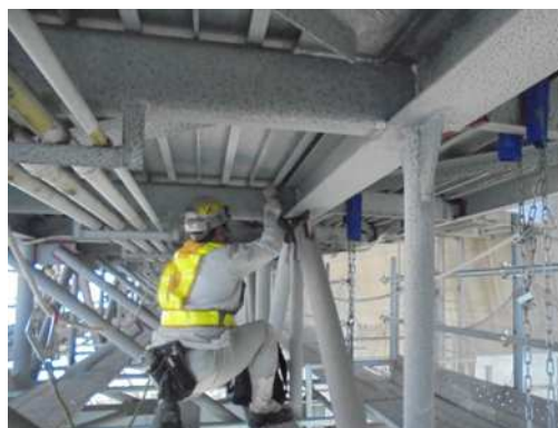
点検状況（機械設備）
