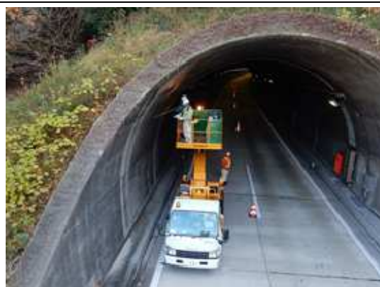
点検状況(土木)
