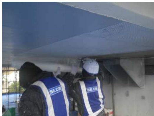
コンクリート剥落対策
