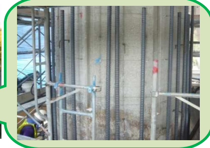
コンクリート橋脚の補強(垂水 IC I ランプ橋)
