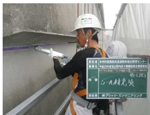
アンカレイジの漏水対策(シール補修) (一般国道30号 南備讃瀬戸大橋7A)
