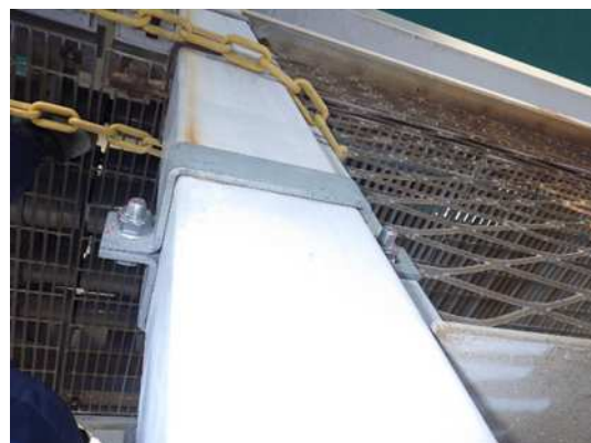
管理用通路側面パネル (補修後)
