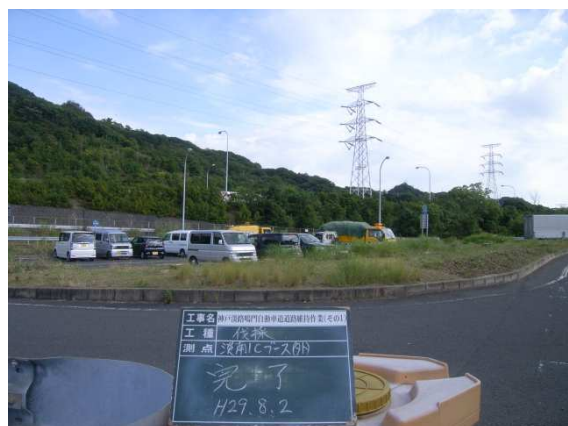
料金所周辺伐採 作業後
