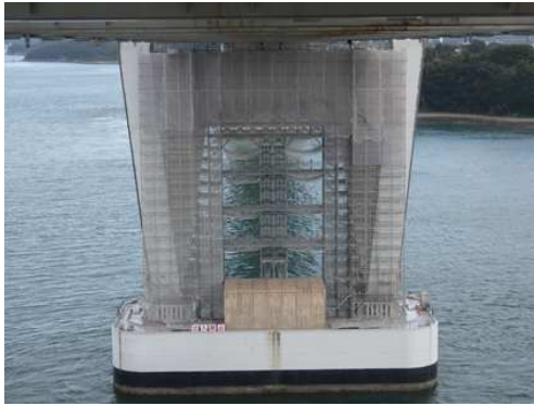
瀬戸大橋塗替塗装足場架設状況
