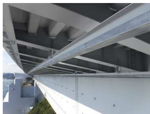
門崎高架橋作業車レール金属溶射完了
