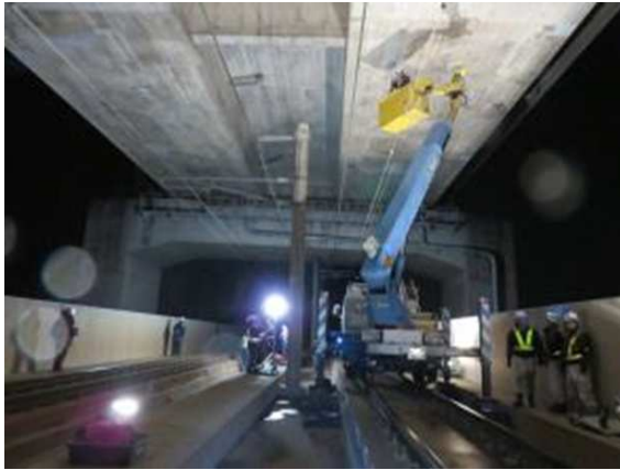
ＪＲ軌道上高架橋の打音点検
