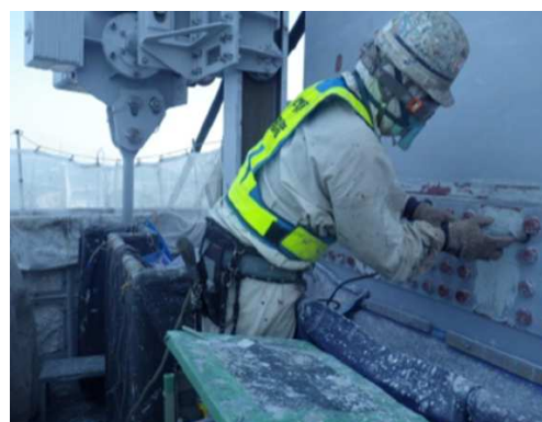
塗替塗装状況 一般国道 30 号 瀬戸大橋
