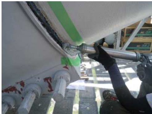
瀬戸大橋 ケーブルバンドシール補修
