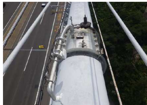
送気カバー配管の補修 (一般国道 28 号 大鳴門橋)
