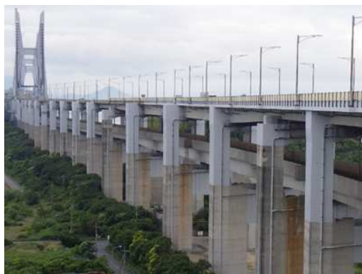
橋脚のASR対策(天端・側面) (一般国道30号 櫃石島高架橋)
