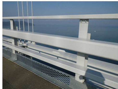
自動車防護柵の補修 (一般国道 28 号 大鳴門橋)
