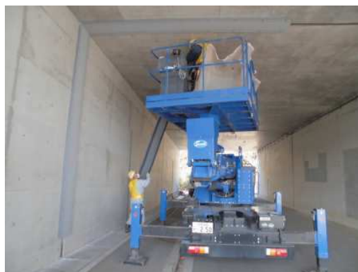
緊急対応（目地部剥落対策）
