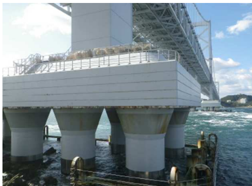
大鳴門橋多柱基礎防食完了
