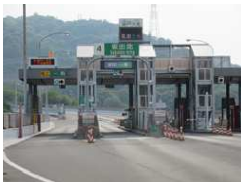
坂出北料金所の安全通路設置状況
