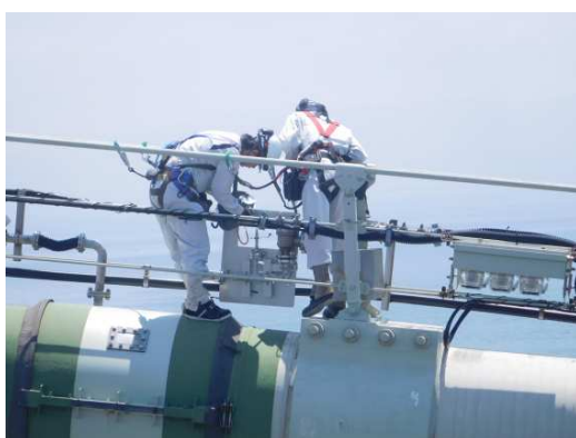
点検状況（長大橋）
