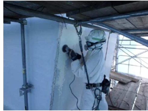
瀬戸大橋塗替塗装(素地調整)実施状況
