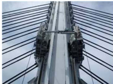
長大橋塗替塗装（瀬戸大橋）
