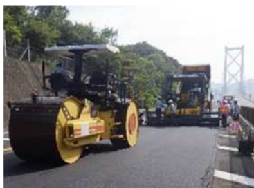
舗装補修（西瀬戸自動車道）
