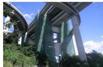
耐震補強（瀬戸中央自動車道）
