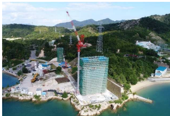
長大橋技術支援（愛媛県受託/岩城橋）
