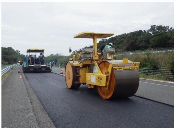
舗装補修工事（切削オーバーレイ工）
