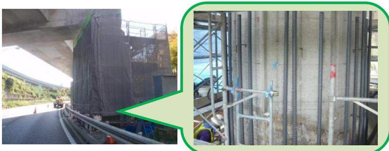
コンクリート橋脚の補強(垂水 IC I ランプ橋)
