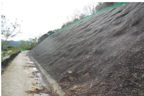
のり面防災対策（落石防護網工）
