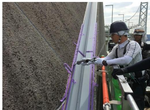
アンカレイジの漏水対策(シール補修)
