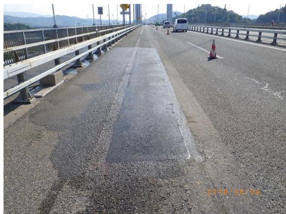
舗装補修工事（ポットホール補修）
