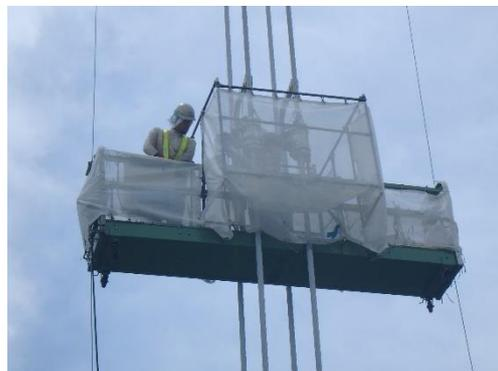
吊橋ハンガーロープの塗替塗装状況
