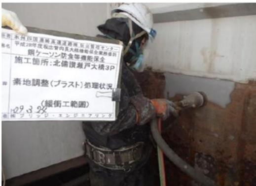
飛沫・干満帯の素地調整作業
