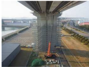
耐震補強（瀬戸中央自動車道）
