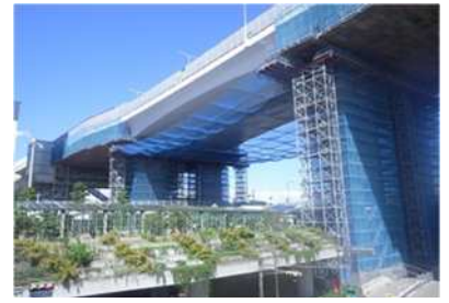
大規模修繕（神戸淡路鳴門自動車道）
