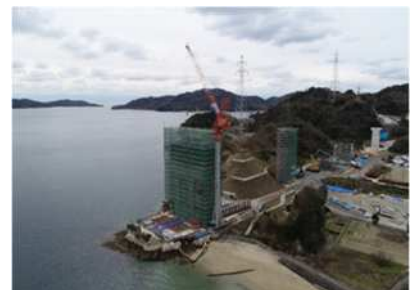
長大橋技術支援（愛媛県受託/岩城橋）
