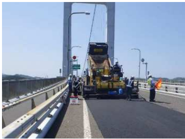
舗装補修（西瀬戸自動車道）
