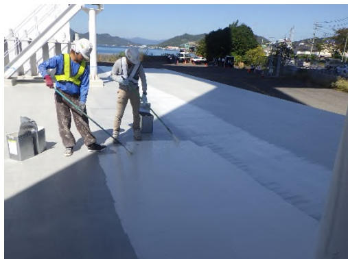
主塔基礎の塩害対策(天端) (一般国道 317 号 生口橋)
