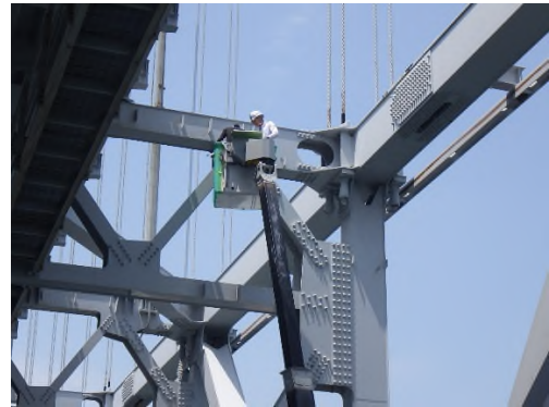
大鳴門橋局部補修塗装実施状況
