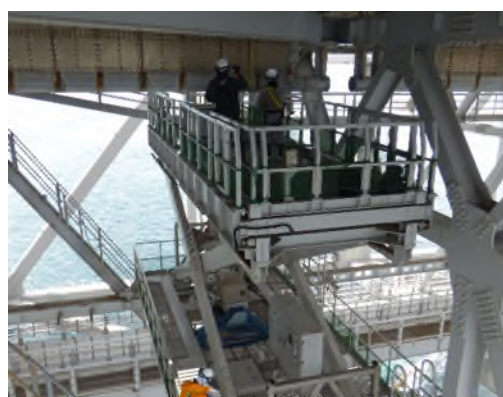
点検状況（長大橋）
