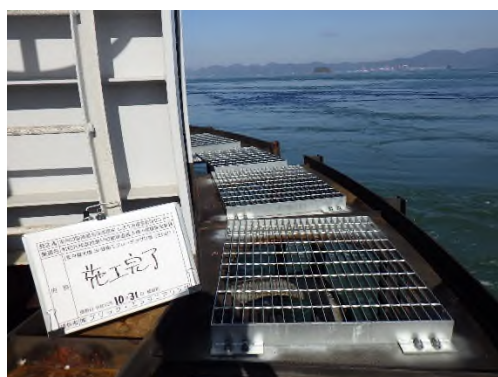
管理路（グレーチング）補修 (一般国道 317 号 多々羅大橋)
