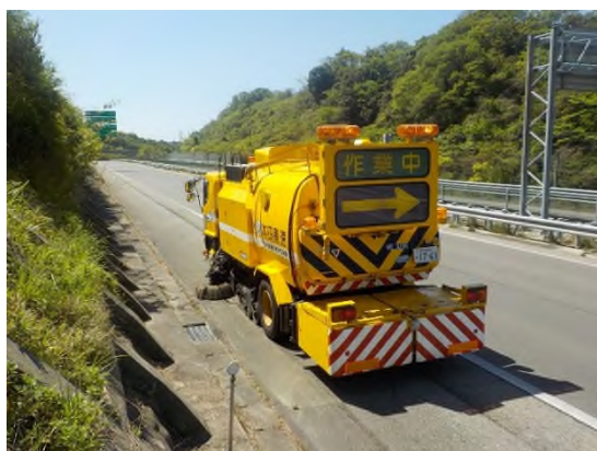
清掃作業（路面清掃）
