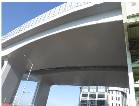
橋梁（桁）の表面被覆工施工状況
