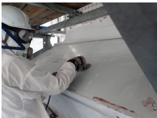
塗替塗装状況 （一般国道 30 号 瀬戸大橋）
