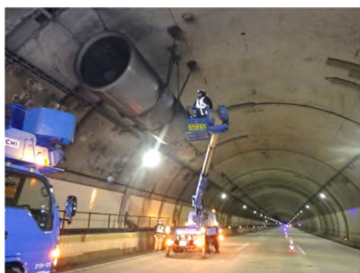
点検状況（機械設備）
