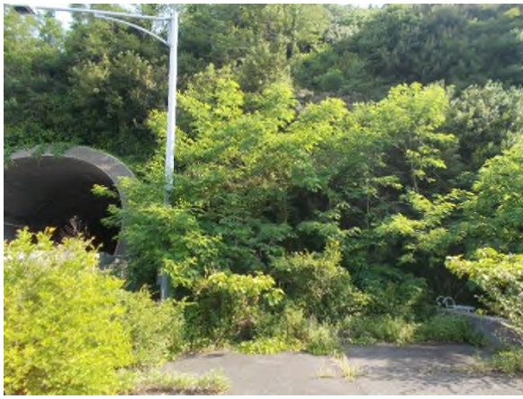
トンネル抗口付近倒木対策 作業前
