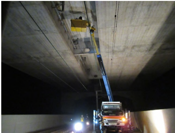
ＪＲ軌道上高架橋の打音点検
