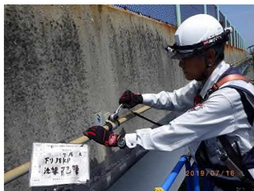
点検状況（電気通信施設）
