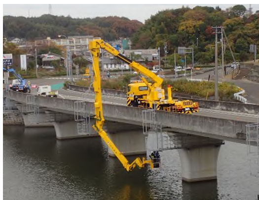
点検状況（土木）
