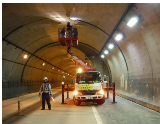
点検状況(土木)
