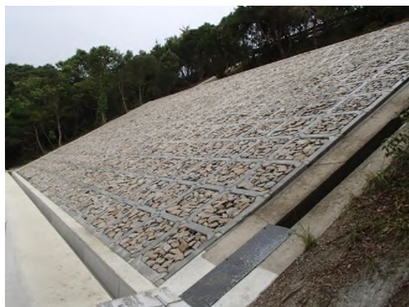
のり面防災対策（のり枠工）
