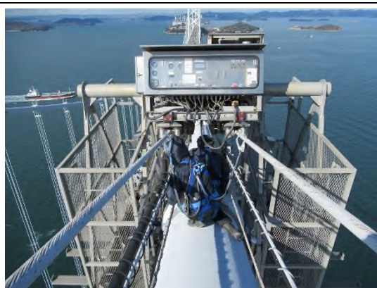
点検状況（長大橋）
