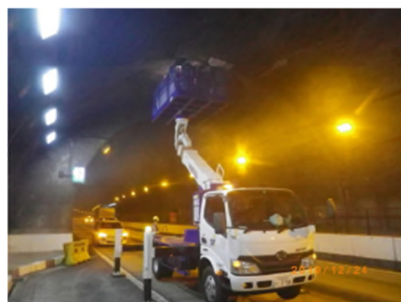
緊急対応（目地部剥落対策）
