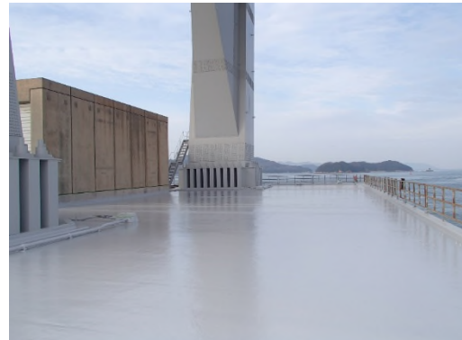
瀬戸大橋コンクリート塗装完了
