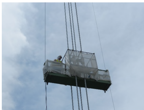
吊橋ハンガーロープの塗替塗装状況 (一般国道 317 号 因島大橋)
