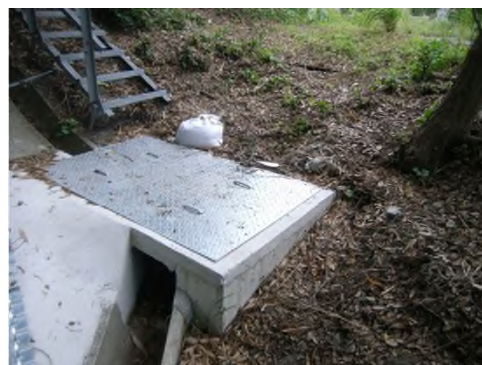
土構造物 排水溝・集水ます改良
