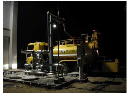
凍結防止剤積込状況
