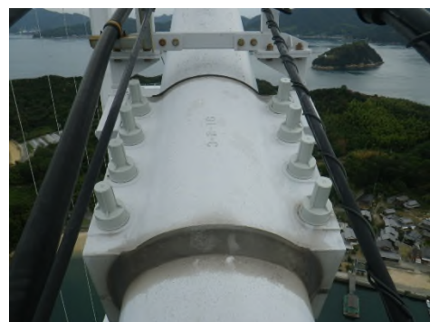
ケーブルバンドボルトキャップの交換 (一般国道 317 号 来島海峡第三大橋)
