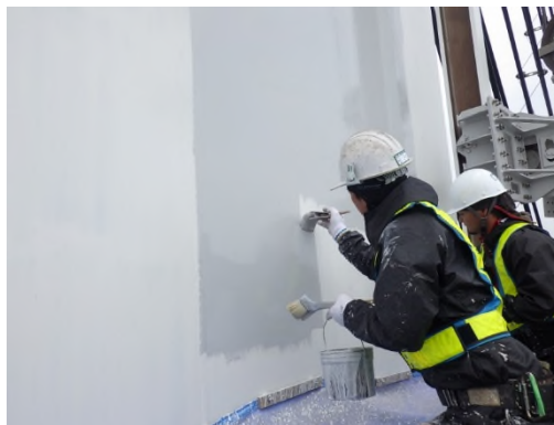
塗替塗装状況 （一般国道 30 号 瀬戸大橋）
