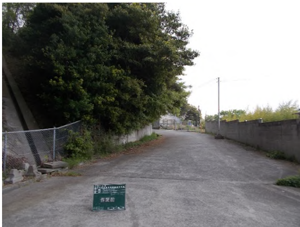
支障木伐採 作業前
