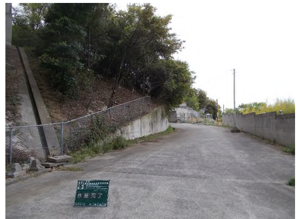
支障木伐採 作業後
