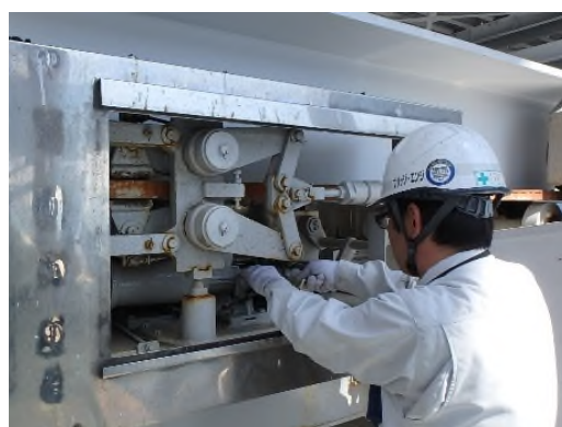
点検状況（機械設備）
