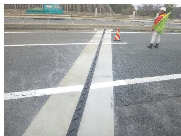
伸縮装置取替
