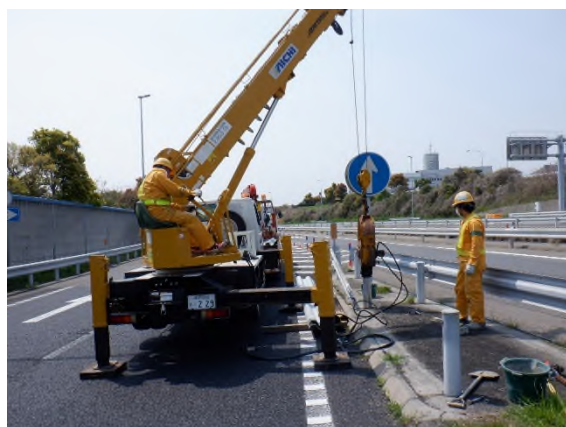
ガードレール取替
