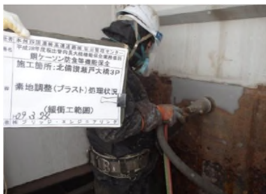
飛沫・干満帯の素地調整作業 (一般国道 30 号 北備讃瀬戸大橋 3P)
