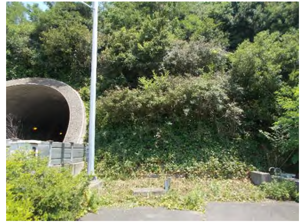
トンネル抗口付近倒木対策 作業後
