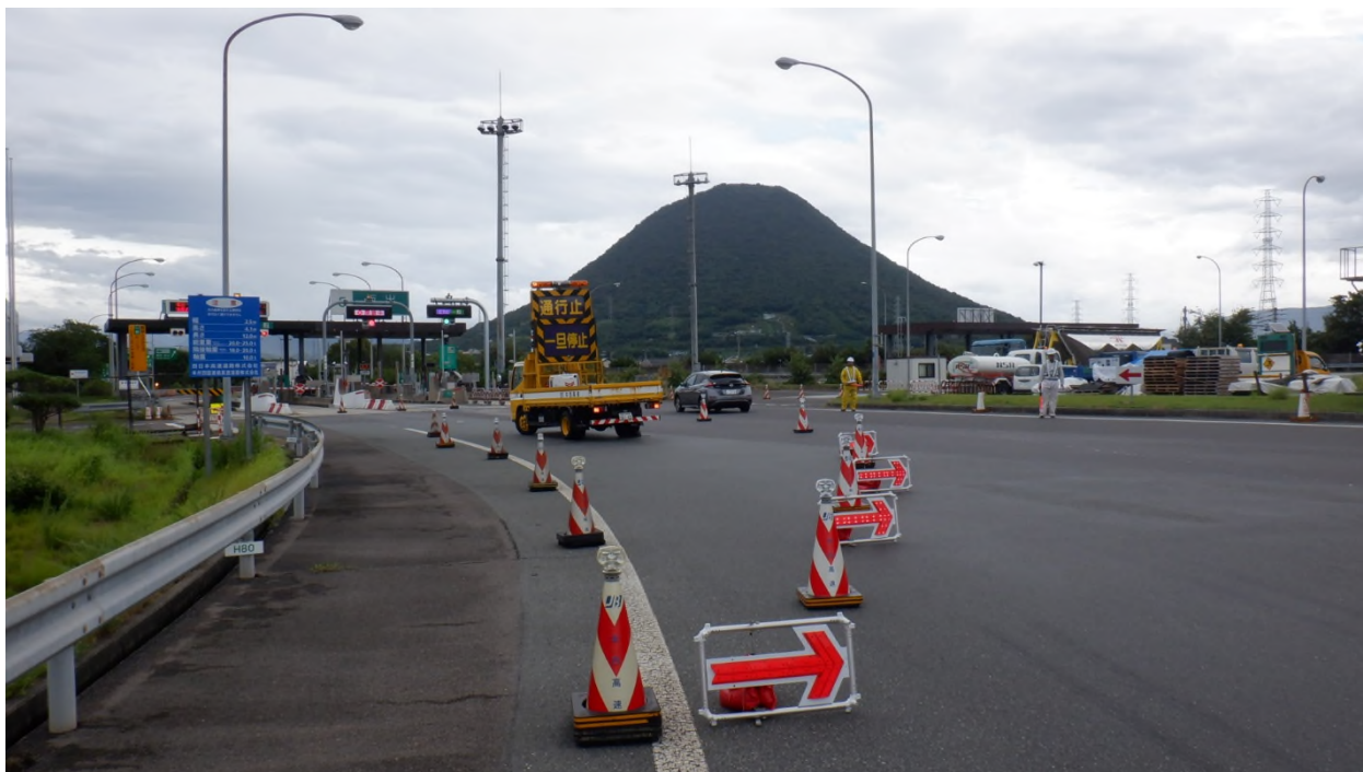
通行止め時の I Cでの案内誘導状況
