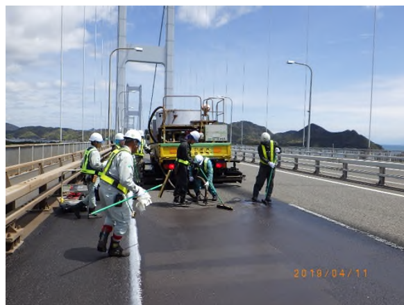
舗装補修工事（路面表面処理工）
