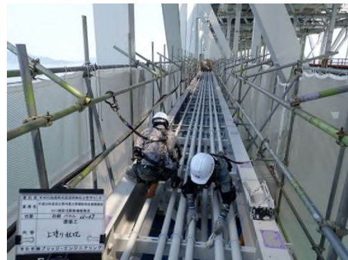
瀬戸大橋管理路・電線管補修塗装実施状況
