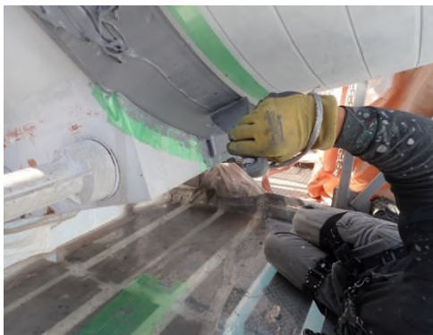
瀬戸大橋ケーブルバンドシール補修
