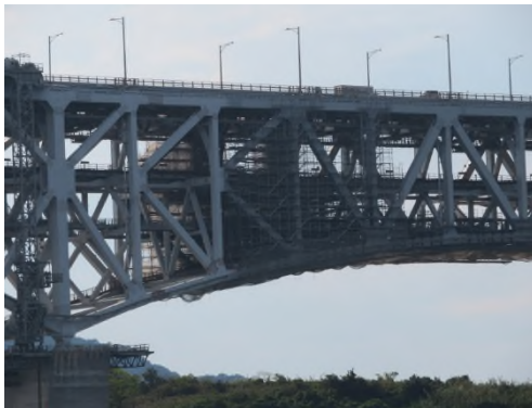
瀬戸大橋塗替塗装足場架設状況
