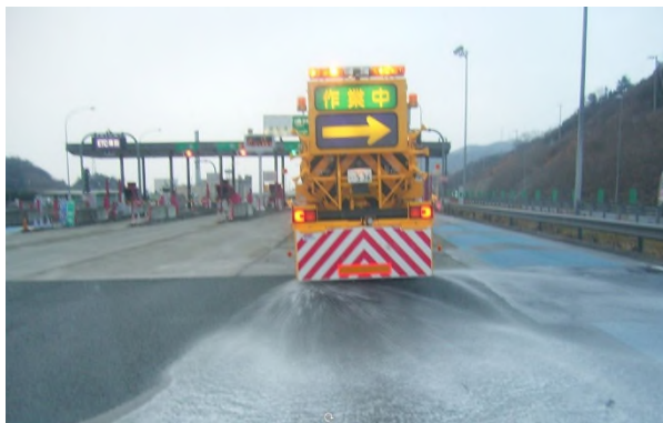
凍結防止剤散布状況
