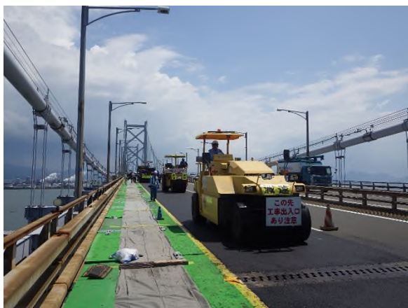
舗装補修工事（切削オーバーレイ工）
