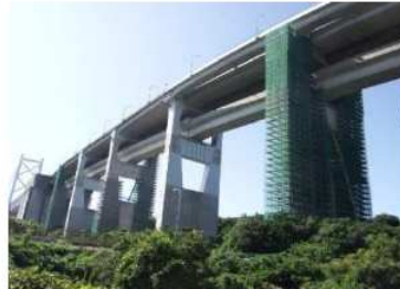
橋梁耐震補強(瀬戸中央自動車道)
