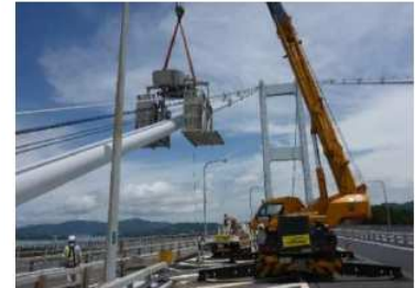
ケーブル補修(西瀬戸自動車道)
