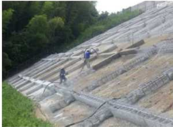
のり面補強(神戸淡路鳴門自動車道)
