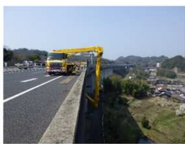
橋梁近接点検 (瀬戸中央自動車道)
