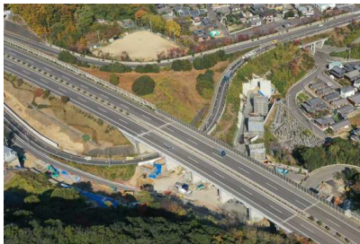
坂出北 I Cフルインター化 (瀬戸中央自動車道)
