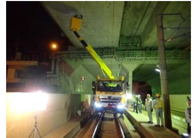
橋梁近接点検 (瀬戸中央自動車道)
