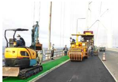
舗装補修 (神戸淡路鳴門自動車道)
