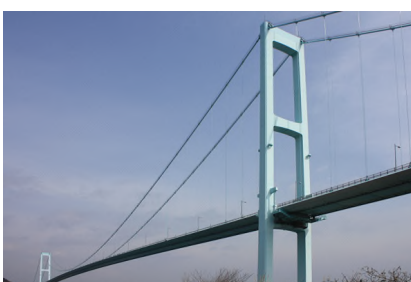
長大橋技術支援 (広島県/安芸灘大橋)
