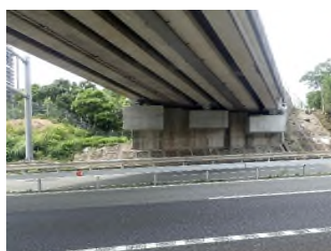
跨道橋耐震補強工事 (兵庫県/伊弉橋)
