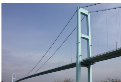
長大橋技術支援 (広島県/安芸灘大橋)
