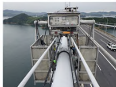
主ケーブル補修 (西瀬戸自動車道)
