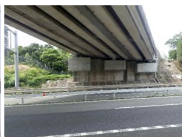
跨道橋耐震補強工事 (兵庫県/伊弉橋)
