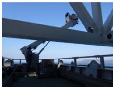
トラス桁点検 (神戸淡路鳴門自動車道)
