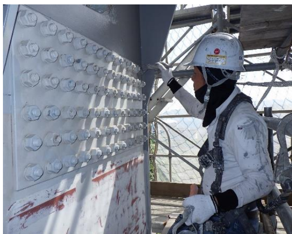
塗替塗装状況 （一般国道 30 号 瀬戸大橋）
