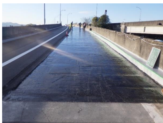
舗装補修工事（床版防水工）
