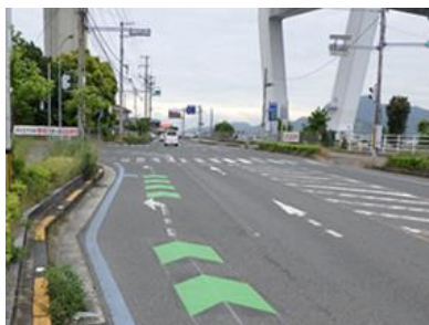
ICの一般道路側接続部における逆走対策（カラー舗装）
