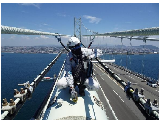
点検状況（長大橋）
