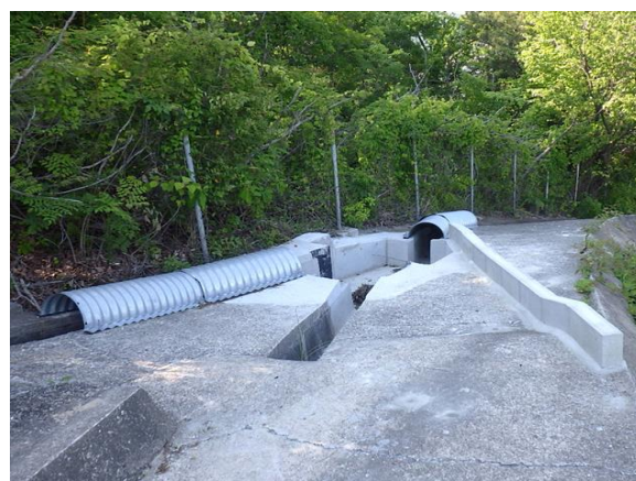
土構造物（のり面） 排水ます改良
