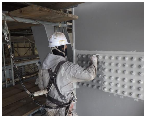
塗替塗装状況 （一般国道 30 号 瀬戸大橋）
