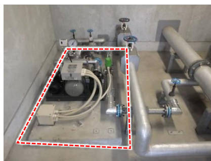
橋梁防災設備修繕（補修後）
