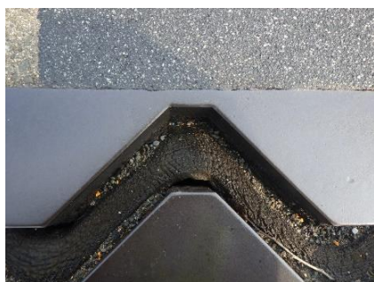
伸縮装置補修（補修前）
