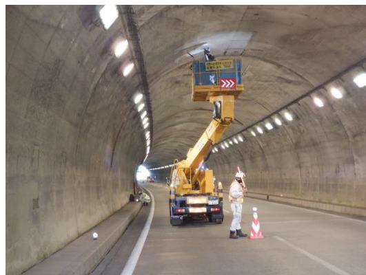
点検状況（土木）
