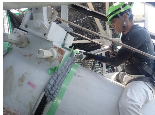
ケーブルバンドシール補修状況 (一般国道 30 号 下津井瀬戸大橋)
