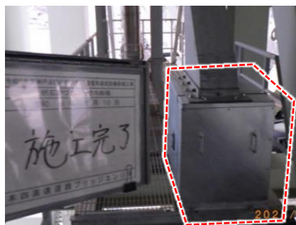
橋梁配線用 BOX（補修後）
