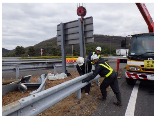
ガードレール取替工事
