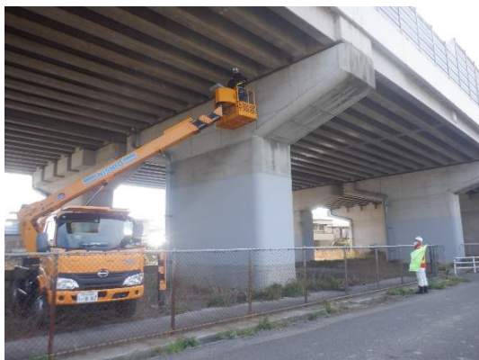
点検状況（土木）
