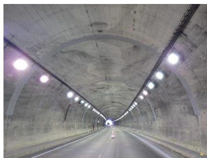
トンネルはく落対策（補修後）
