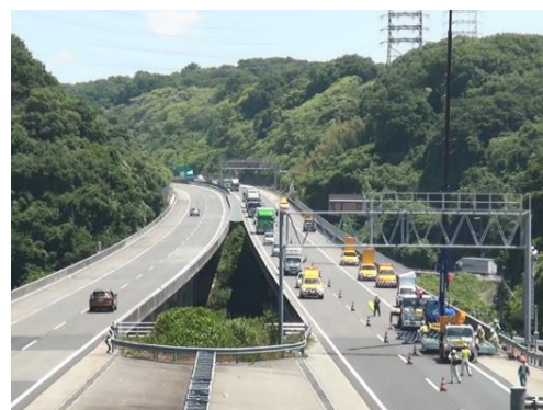
低速走行規制による大型標識撤去作業(左が撤去中、右が撤去完了)
