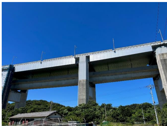
橋梁（桁） 表面被覆工
