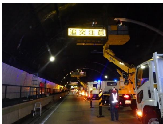
はく落対策工事（トンネル）
