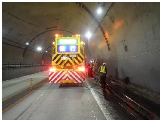
清掃作業（トンネル清掃）
