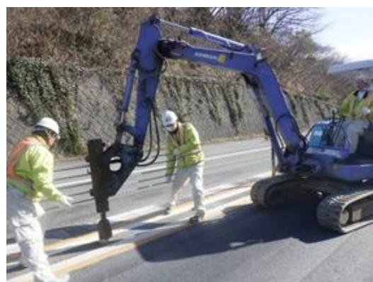
中分ワイヤロープ復旧工
