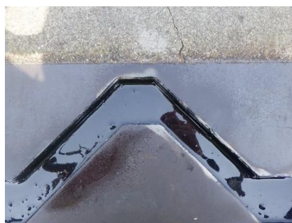
伸縮装置補修（補修後）
