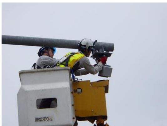
点検状況（電気通信施設）
