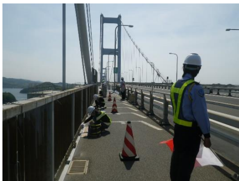
舗装止めの補修 (一般国道 317 号 来島海峡大橋)
