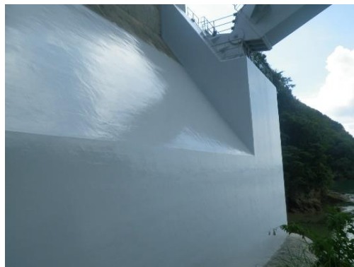
橋台コンクリートの補修 (一般国道 317 号 大三島橋)
