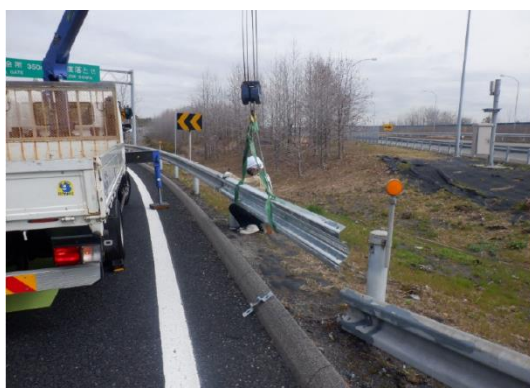
ガードレール復旧工
