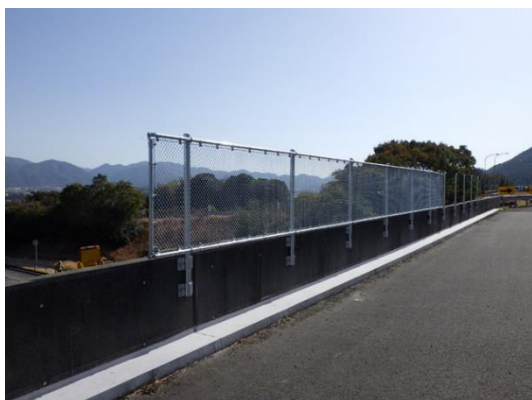
落下物防止柵設置工事
