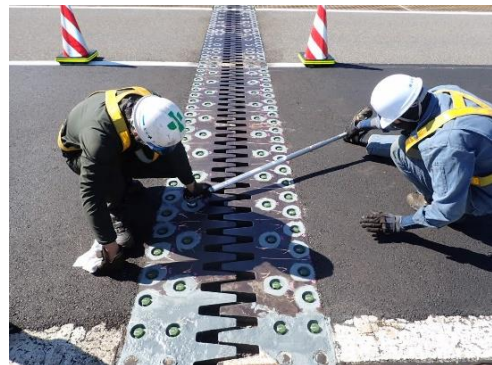
鋼床版伸縮装置の補修 (一般国道 30 号 瀬戸大橋)
