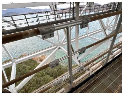
管理用通路（補修後）
