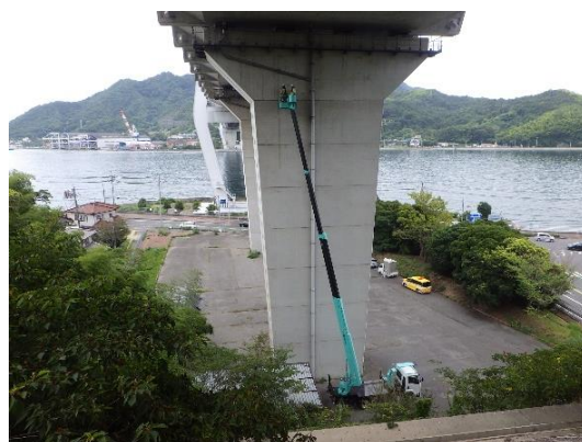
点検状況（長大橋）
