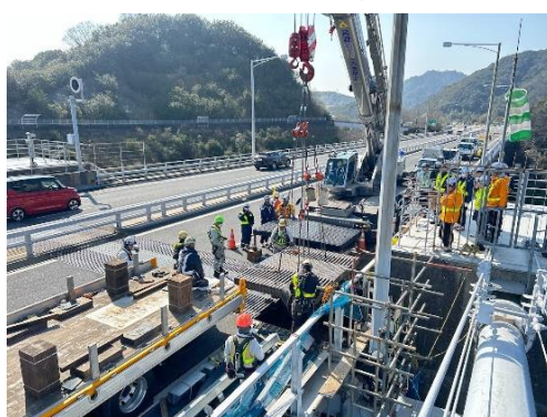
因島大橋 大型伸縮装置交換状況
