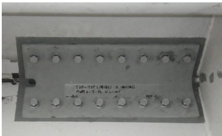
鋼床版下面からの亀裂補修方法
