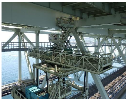
明石海峡大橋 補修塗装状況
