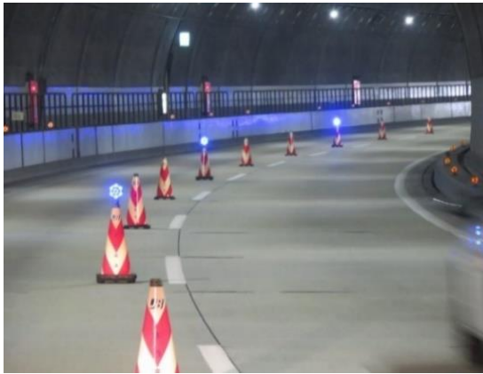
超高輝度 LED 搭載の自発光デリニエーター
