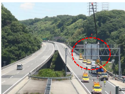
低速走行規制による大型標識撤去作業(左が撤去中、右が撤去完了)
