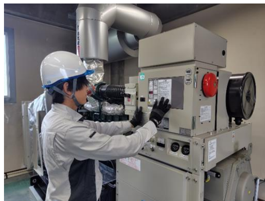
点検状況（電気通信施設）
