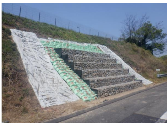
のり面補修工事（ふとんかご工）
