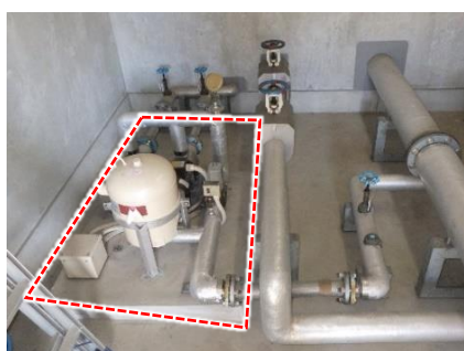
橋梁防災設備修繕（補修前）
