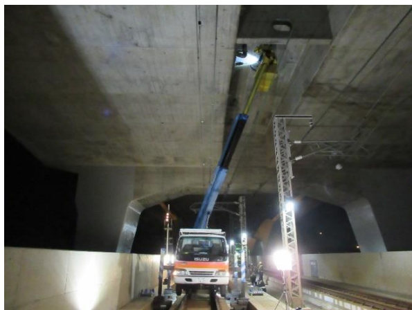
JR軌道上高架橋の打音点検
