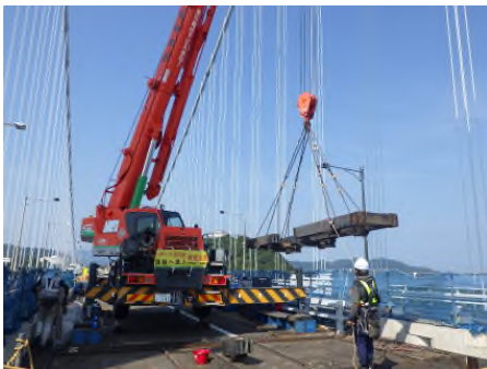
大鳴門橋 伸縮装置補修 (神戸淡路鳴門自動車道)
