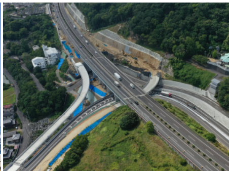
(仮称) 坂出北 SIC 改築工事 (瀬戸中央自動車道)
