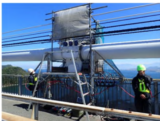
来島海峡大橋 ケーブルバンドボルト増締め状況
