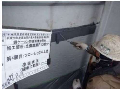
飛沫・干満帯の塗装作業 (一般国道 30 号 北備讃瀬戸大橋3P)
