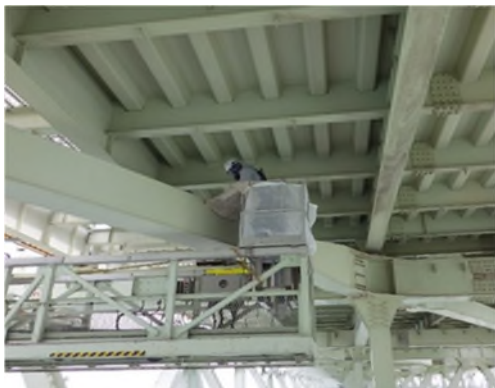
明石海峡大橋 補修塗装状況
