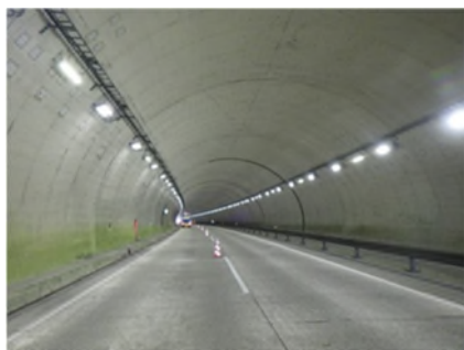
トンネルはく落対策（補修前）
