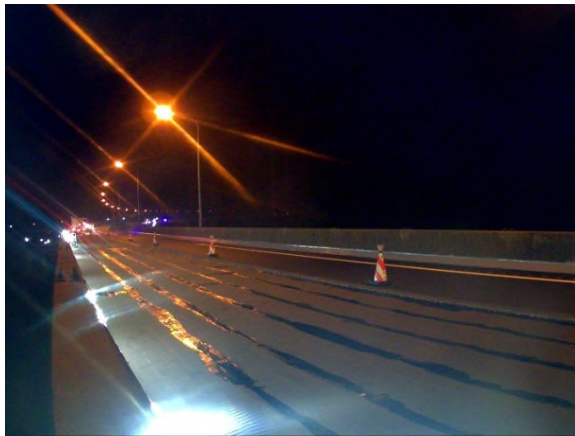
橋梁（床版） 高性能床版防水工
