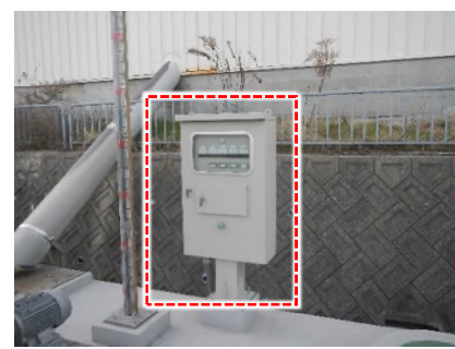
凍結防止設備制御盤（補修後）
