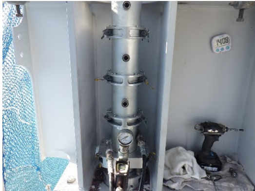
吊橋ハンガーロープの内部充填 (一般国道 30 号 瀬戸大橋)
