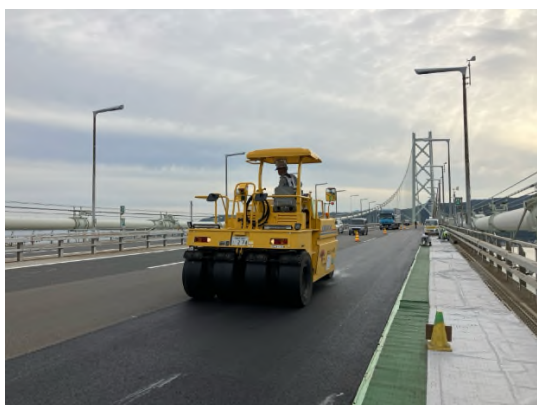
舗装補修工事（切削オーバーレイ工）
