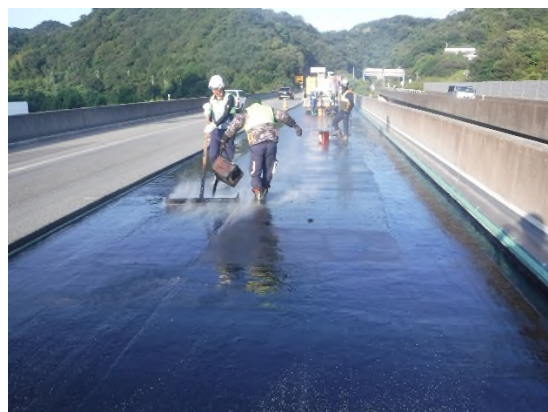
舗装補修工事（床版防水工）
