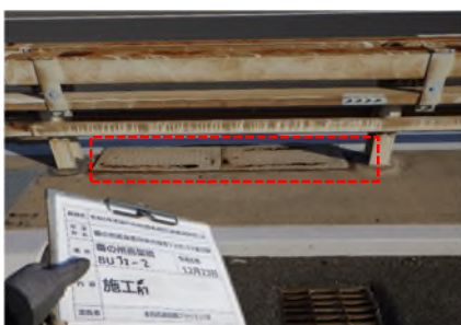
橋梁配線用プルボックス（補修前）
