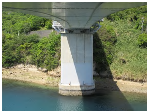
コンクリート橋脚の補修 (一般国道 317 号 伯方橋)
