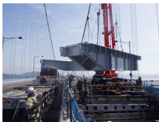
大鳴門橋 大型伸縮装置交換状況
