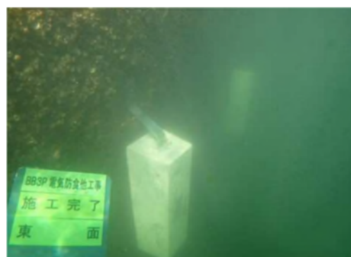
電気防食設備(アルミ陽極)設置状況 (一般国道 30 号 北備讃瀬戸大橋3P)
