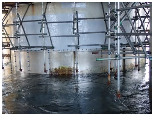
4P 飛沫部塗装、干満部チタンカバー設置状況 (一般国道 28 号 大鳴門橋)
