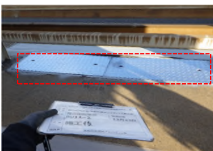
橋梁配線用プルボックス（補修後）
