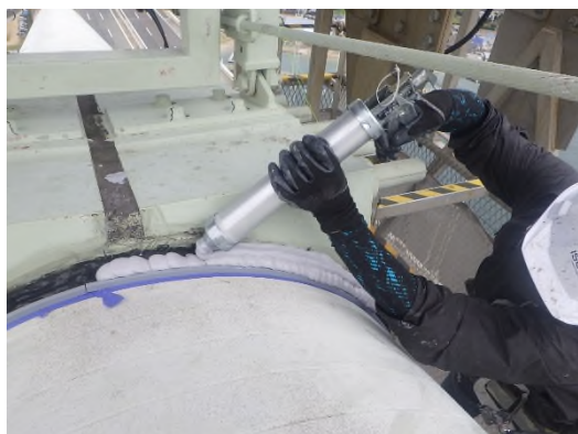
ケーブルバンドシール補修状況 (一般国道 28 号 明石海峡大橋)
