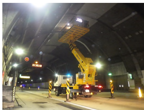
はく落対策工事（トンネル）
