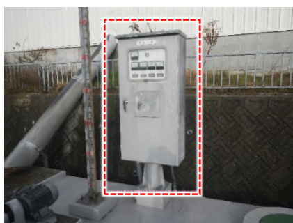
凍結防止設備制御盤（補修前）
