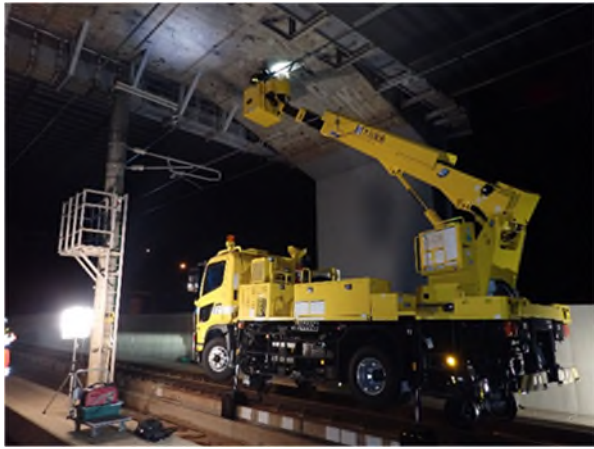
JR軌道上高架橋の打音点検
