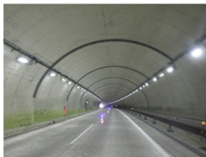
トンネルはく落対策（補修後）
