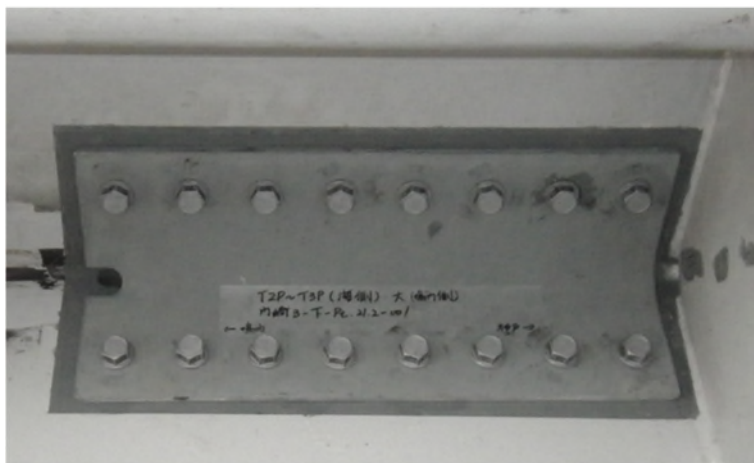
鋼床版下面からの亀裂補修方法
