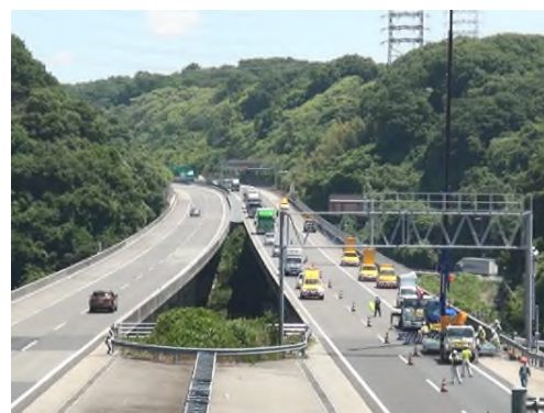
低速走行規制による大型標識撤去作業(左が撤去中、右が撤去完了)
