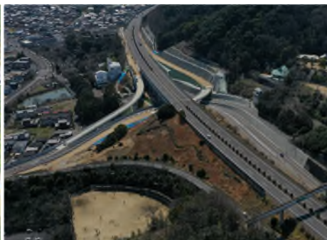
坂出北 SIC 改築工事 (瀬戸中央自動車道)
