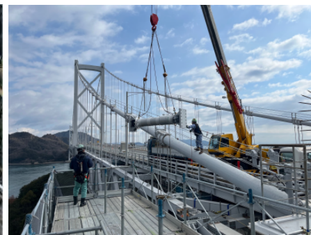
因島大橋 耐震補強工事 (西瀬戸自動車道)
