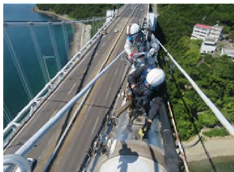
大鳴門橋 ケーブル点検 (神戸淡路鳴門自動車道)
