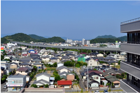
写真—1 撫養高架橋全景
