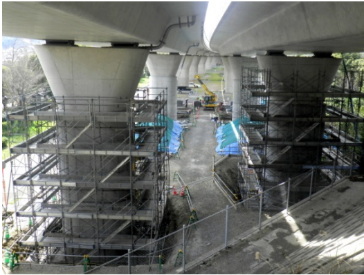
写真—3 橋脚巻立工(施工中)
