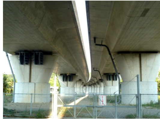
写真—4. 落橋防止工(完成)
