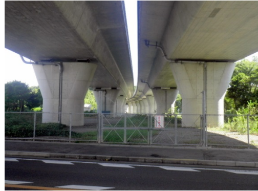
写真—2 全景(施工前)
