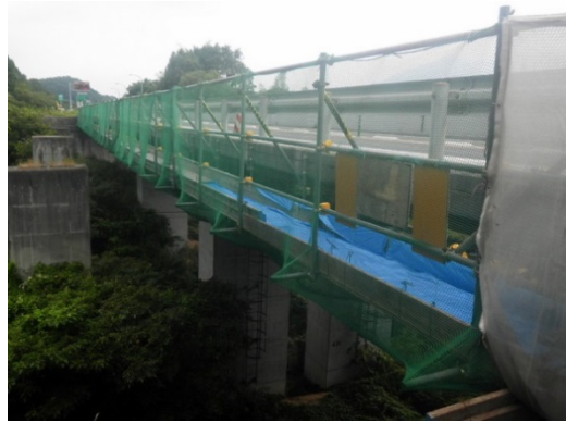
写真—2 永江川橋(施工中)
