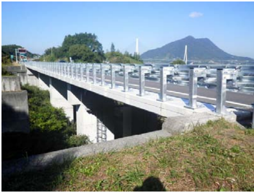
写真—3 永江川橋(完成)
