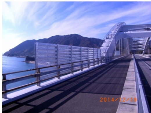
写真—6 大三島橋防風柵(完成)
