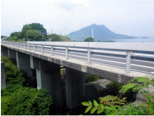
写真—1 永江川橋(施工前)
