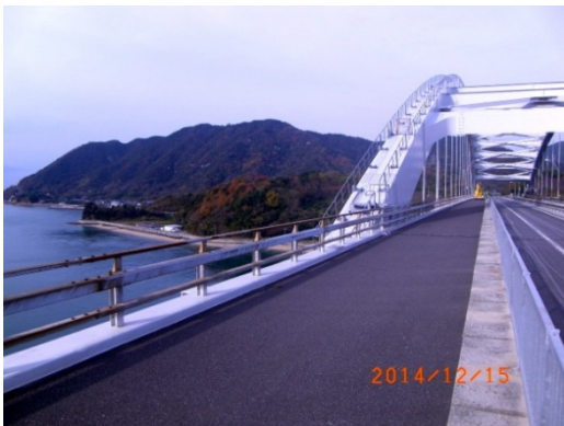
写真—5 大三島橋防風柵(施工前)
