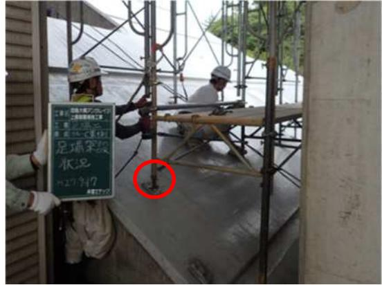
写真-2. 傾斜上での足場架設状況
