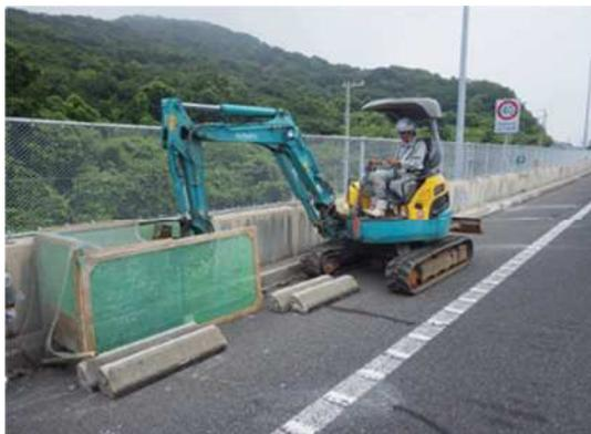
写真-5. 飛び石飛散防止カバーの一例
