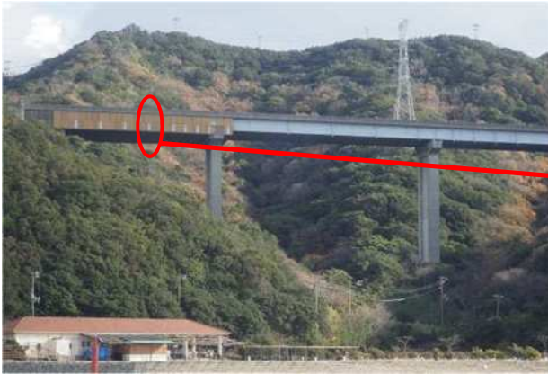
写真-1. 2 側面板張防護工への採光パネルの採用
