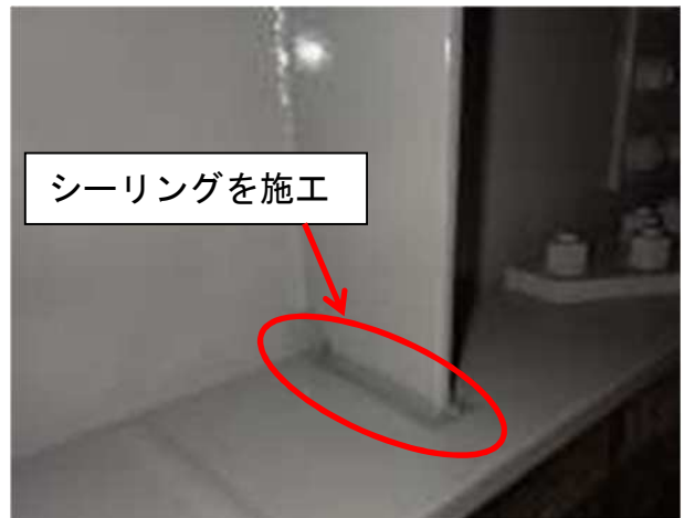
写真-4 シーリング施工による発錆予防
