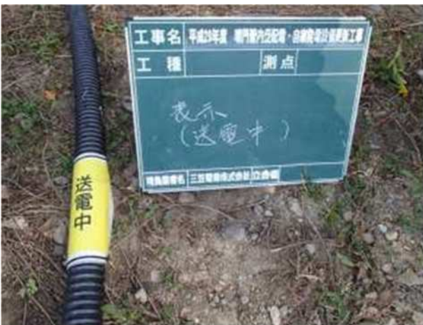
写真-5 仮設設備への明示
