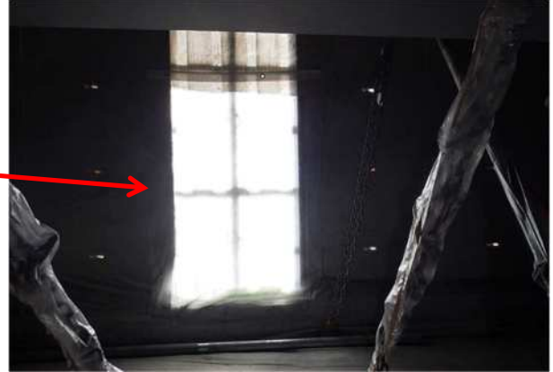
写真-1. 2 側面板張防護工への採光パネルの採用
