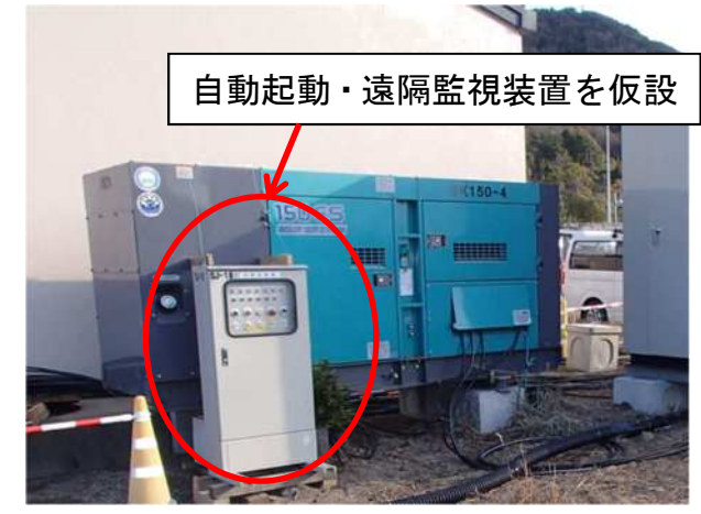
写真-6 自動起動装置等仮設
