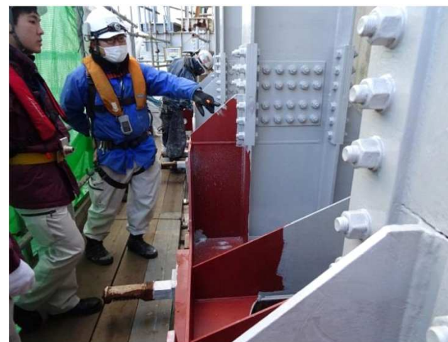
主塔基礎補修塗装施工状況(明石海峡大橋)
