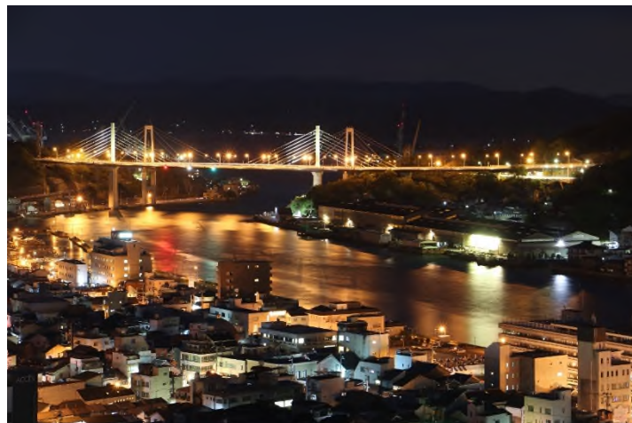
新尾道大橋ライトアップ
