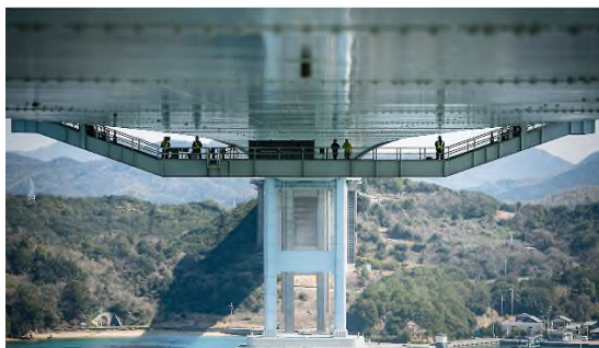
桁外面作業車に乗って空中散歩を初体験
