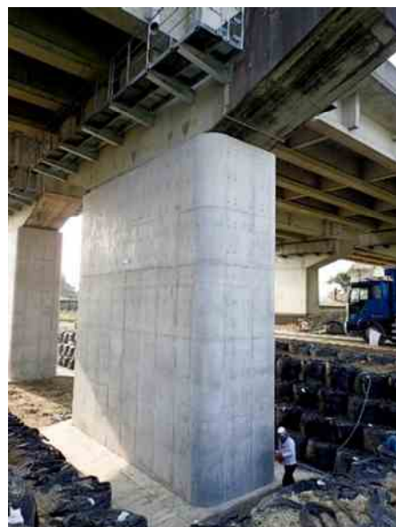
写真－２ 橋脚補強工 (コンクリート巻立て)
