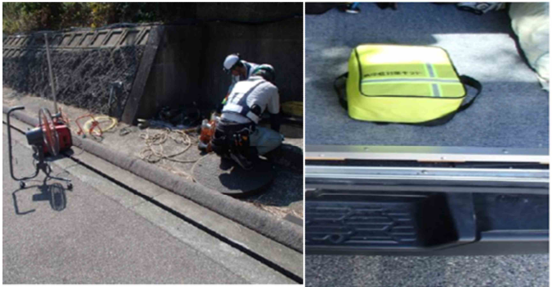
写真－１０ 熱中症対策（扇風機・空調服・熱中症対策キット）
