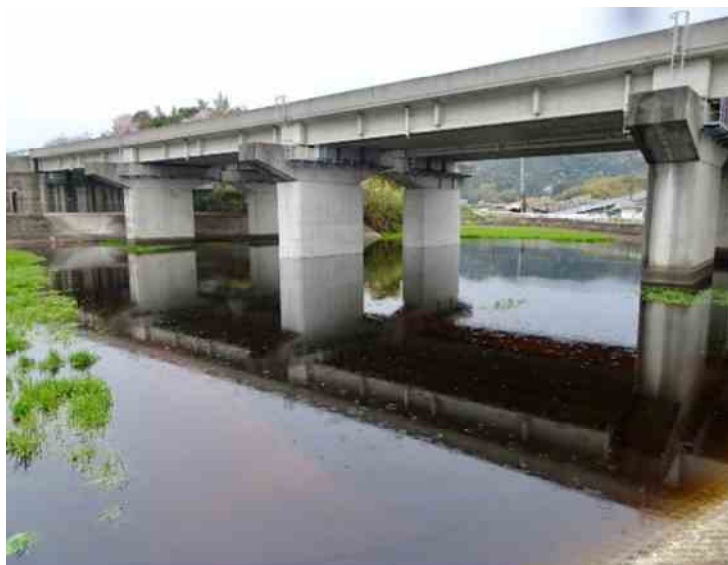
写真－１ ため池での橋脚補強工 (平池橋)
