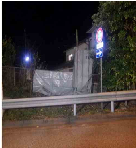
写真－４ 隣接家屋への騒音対策
