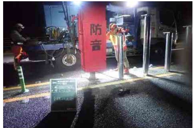
写真－１・２ 支柱打込機への防音装置の取付
