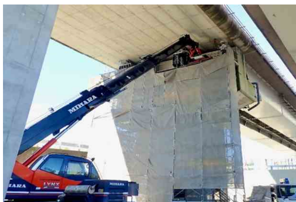
写真－４・５ 落路下利用による部材搬入（志知高架橋新川橋２）
