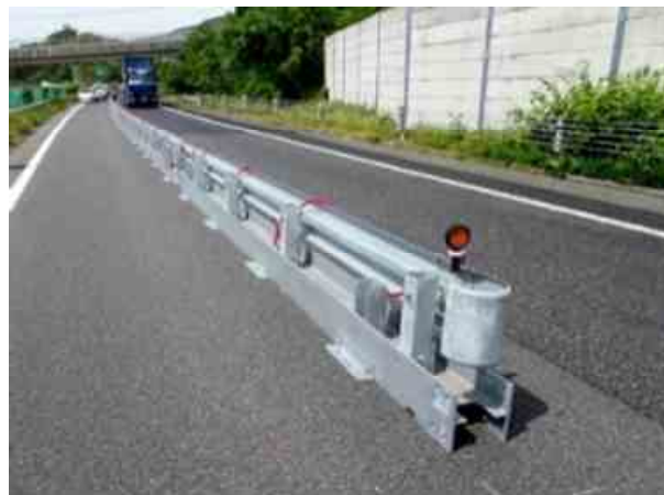
写真－６・７ 中央分離帯の昼夜連続規制での起伏式仮設防護柵（西所跨道橋）
