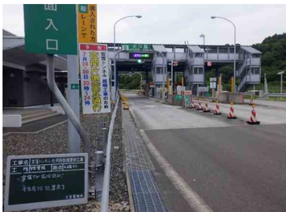
写真－７ 予告看板設置
