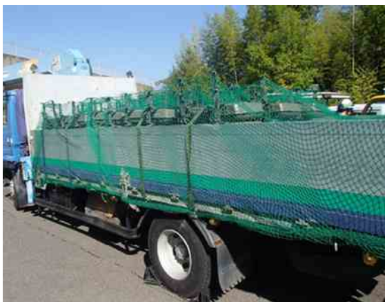
写真－１２・１３ 撤去物の落下・飛散防止対策（照明器具、電源ケーブル）
