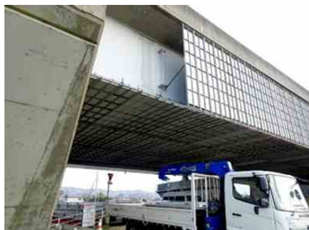
写真－８・９ 県道上のパネル式足場（志知高架橋新川橋 1）
