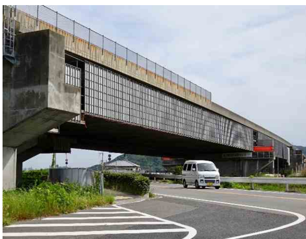
写真－８・９ 県道上のパネル式足場（志知高架橋新川橋 1）
