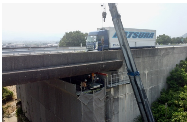
写真－４・５ 落路下利用による部材搬入（志知高架橋新川橋２）
