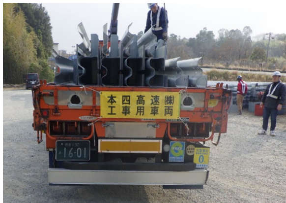
写真－６ 過積載防止：仮設防護柵H鋼
