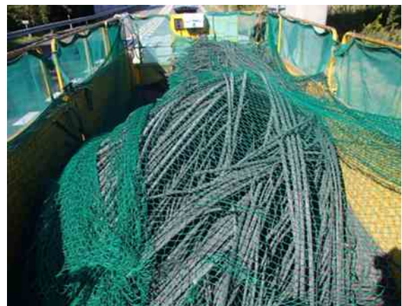
写真－１２・１３ 撤去物の落下・飛散防止対策（照明器具、電源ケーブル）
