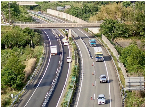
写真－６・７ 中央分離帯の昼夜連続規制での起伏式仮設防護柵（西所跨道橋）
