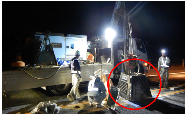
写真－３ 岩削時における飛散防止兼騒音低減対策
