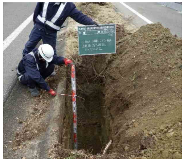
写真－４・５ 土被りが薄い箇所での事前試掘
