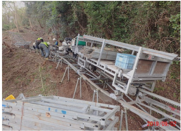
写真－２ 仮設備モノレール
