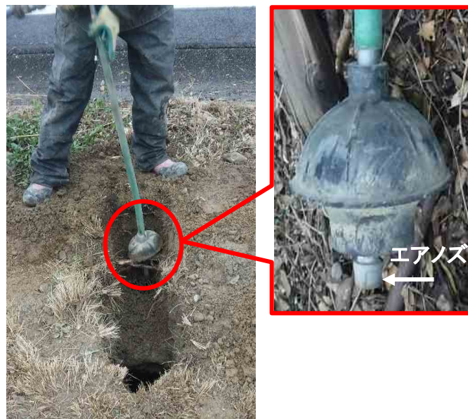
写真－１ エアースコップでの掘削（埋設物損傷事故防止対策）
