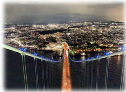
神戸側主塔からの夜景
