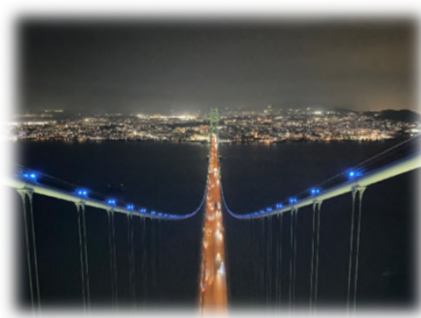
淡路島側主塔からの夜景
