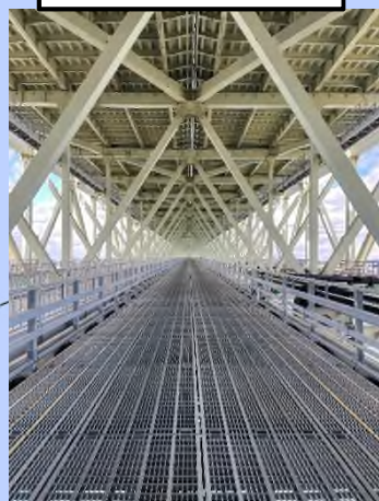
③明石海峡大橋 管理路ウォーク
