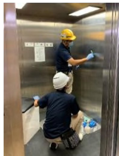
EV抗菌施工
