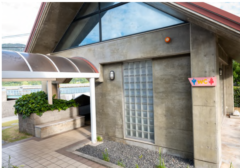
江の浦港の公衆トイレ (讃岐広島)
