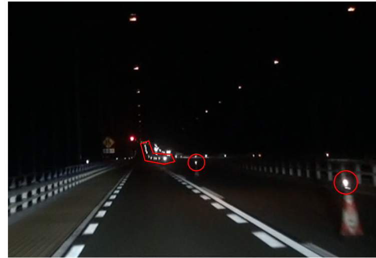
夜間同期点滅式自発光デリネータ設置
