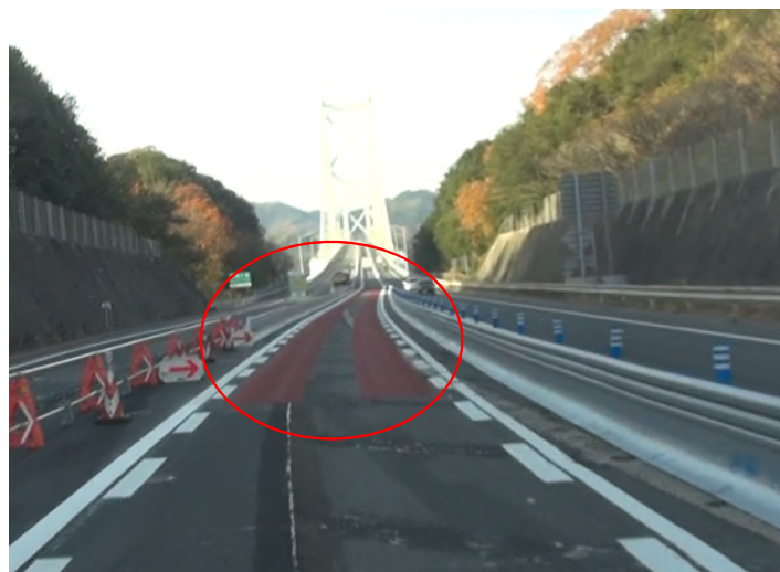
下り線側から上り線側へのシフト区間に カラー舗装による車両誘導
