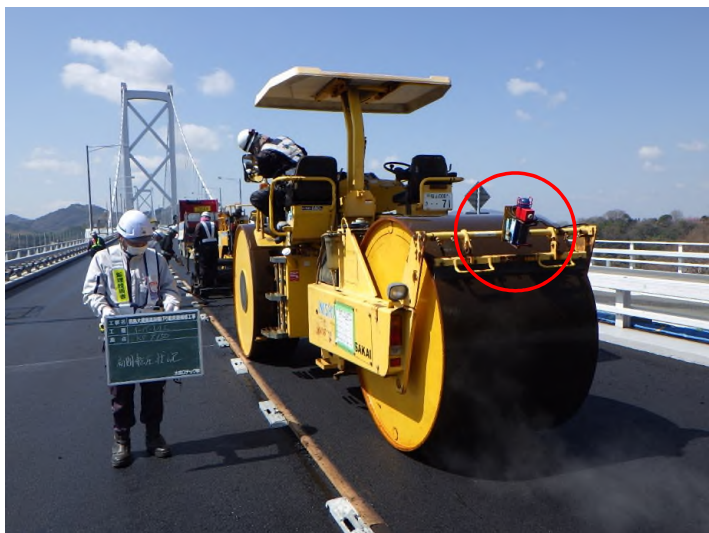
安全補助検知器を設置し施工
