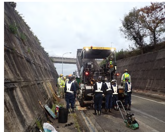
<ランプ部施工状況>
