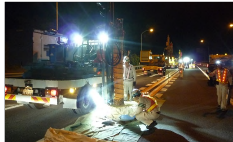
大島道路夜間通行止め内での相乗り施工
