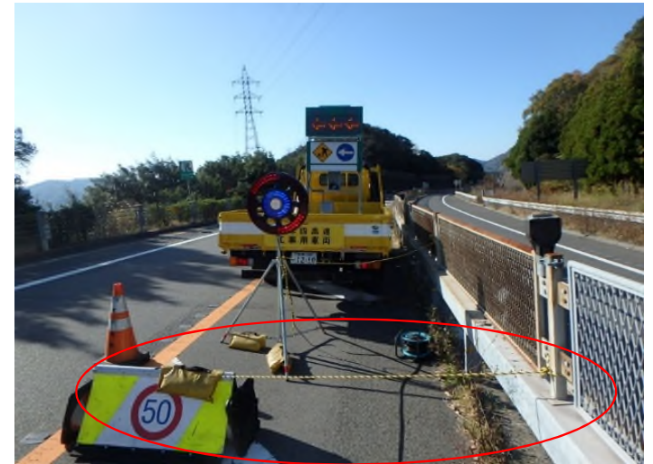
規制機材の飛散防止対策
