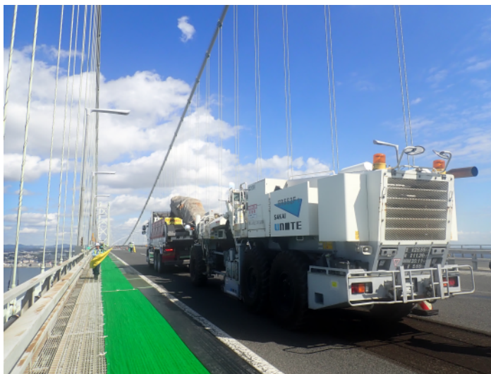
<明石海峡大橋施工状況>
