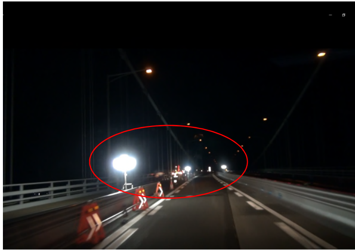
夜間バルーンライト設置
