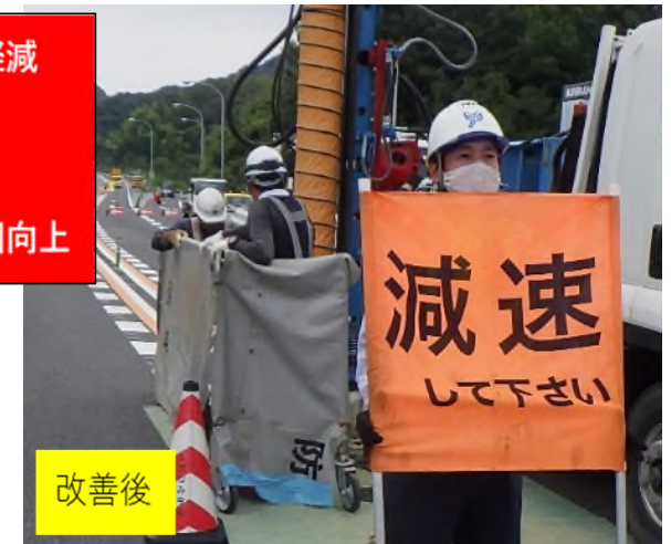
[改善後] 本工事 H=1.0m, L=3.4m, W=0.5m
