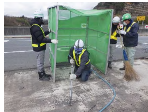
＜はつり時の防護工＞
