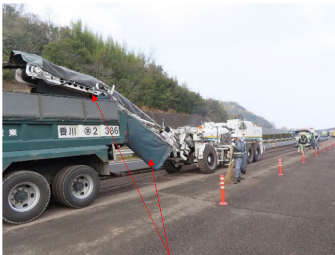
飛散防止カバーの設置
