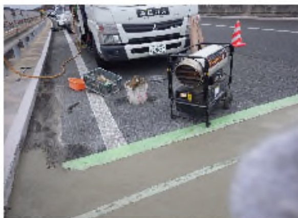
コンクリートの強度発現を促進する 給熱養生(冬期施工)
