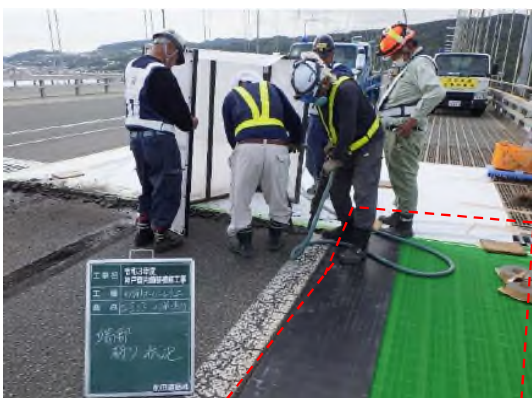
＜グレーチング部の養生＞
