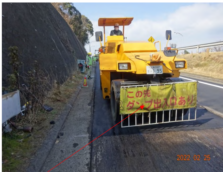
追突防止センサー 巻き込み防止カバー 注意喚起用垂れ幕
