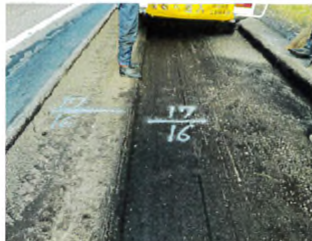
切削路面の作図表示状況
