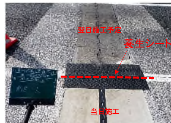
交通解放後、打ち継ぎ目を保護する シート養生
