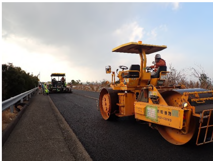
<本線土工部施工状況>
