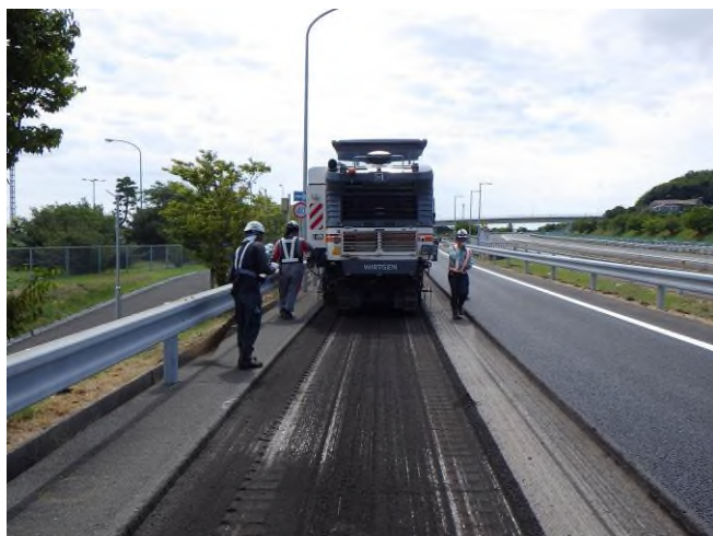
路面切削状況
