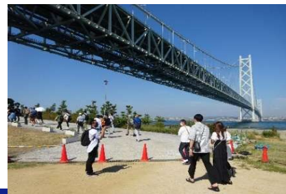
明石海峡大橋塔頂ツアー(移動風景)
