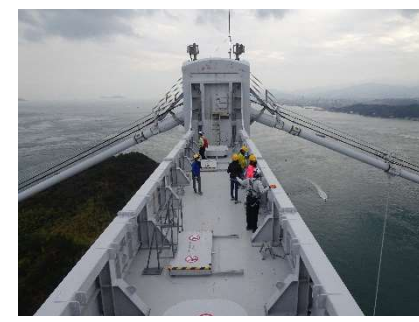
来島海峡大橋塔頂体験(塔頂)
