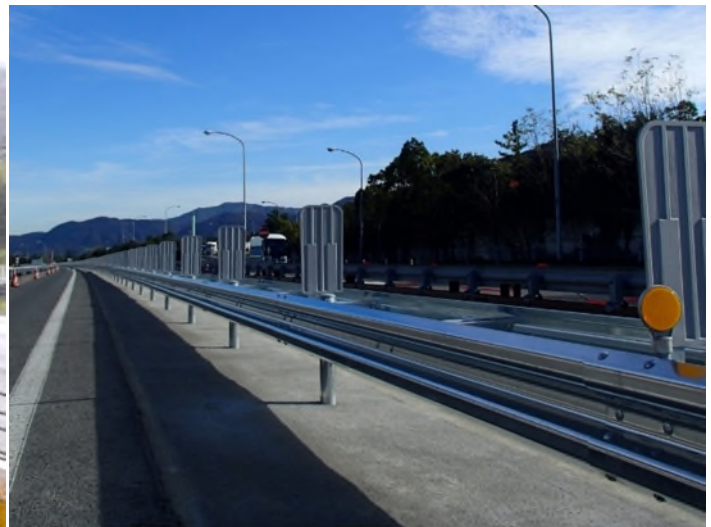
改良後（ガードレール）
