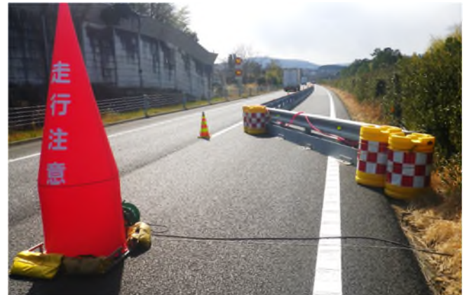
仮設防護柵の設置（過年度実施事例）
