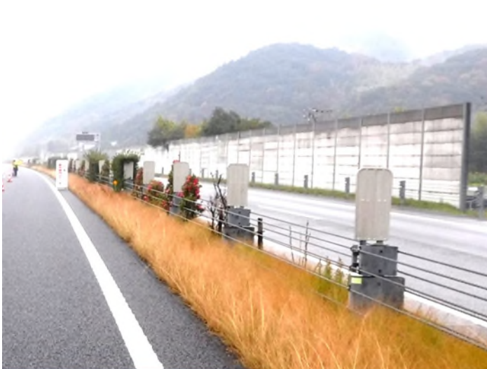
改良前（ガードケーブル）
