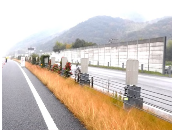
改良前（ガードケーブル）
