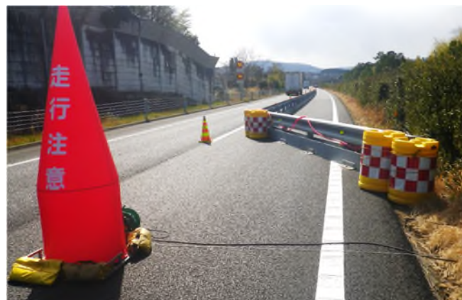
仮設防護柵の設置（過年度実施事例）
