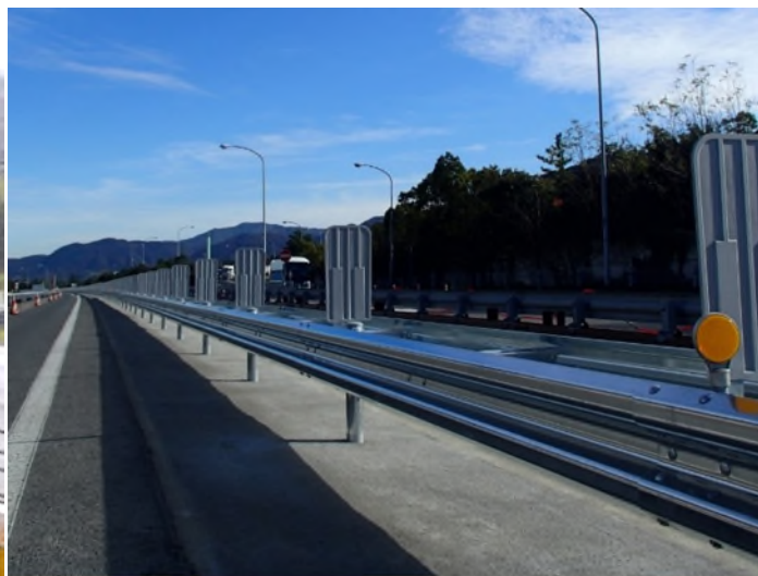
改良後（ガードレール）
