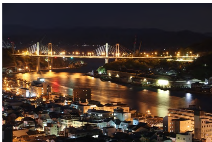
新尾道大橋ライトアップ
