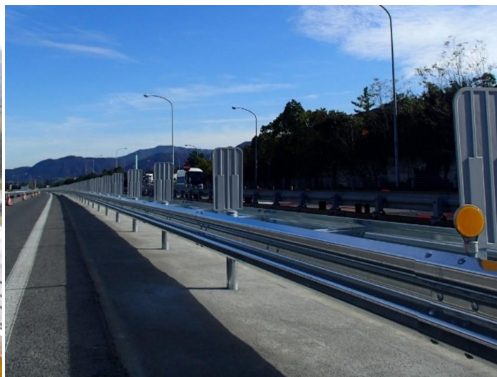
改良後（ガードレール）
