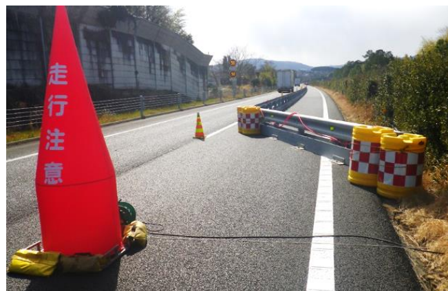
仮設防護柵の設置（過年度実施事例）
