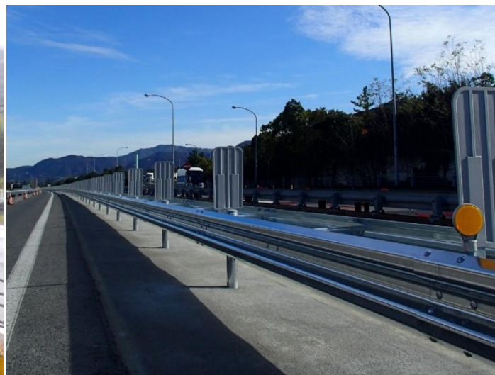
改良後（ガードレール）
