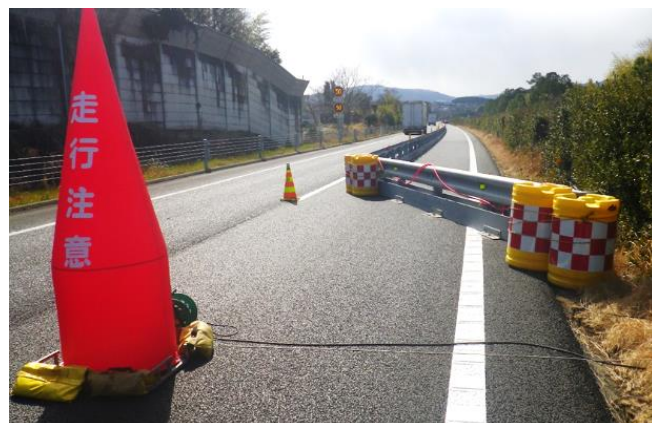
仮設防護柵の設置（過年度実施事例）
