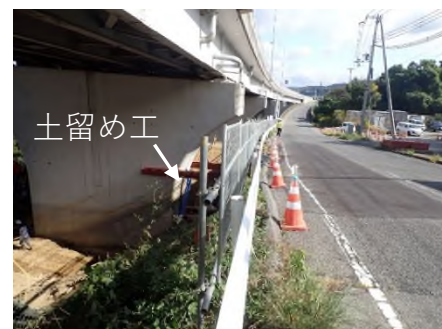
一般道に影響を与えず特殊掘削にて施工中
