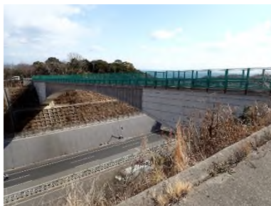
石の寝屋跨道橋（淡路市受託）
