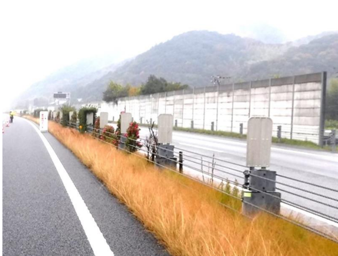
改良前（ガードケーブル）
