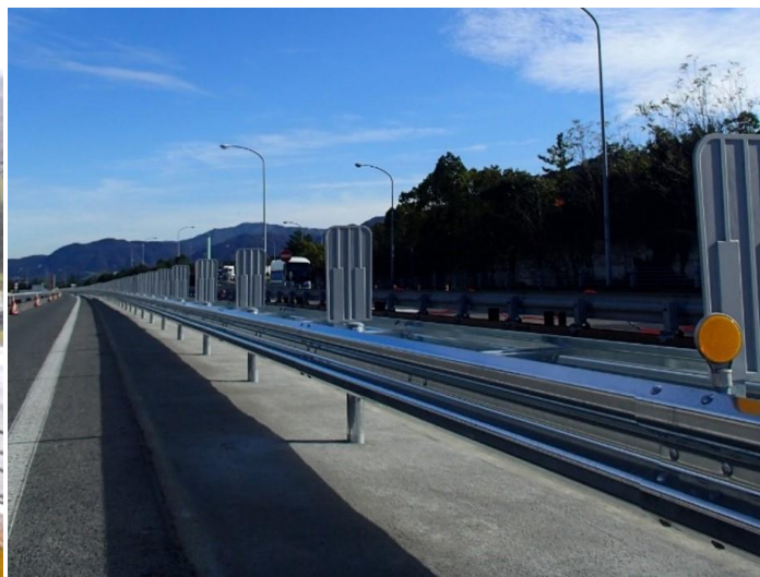
改良後（ガードレール）
