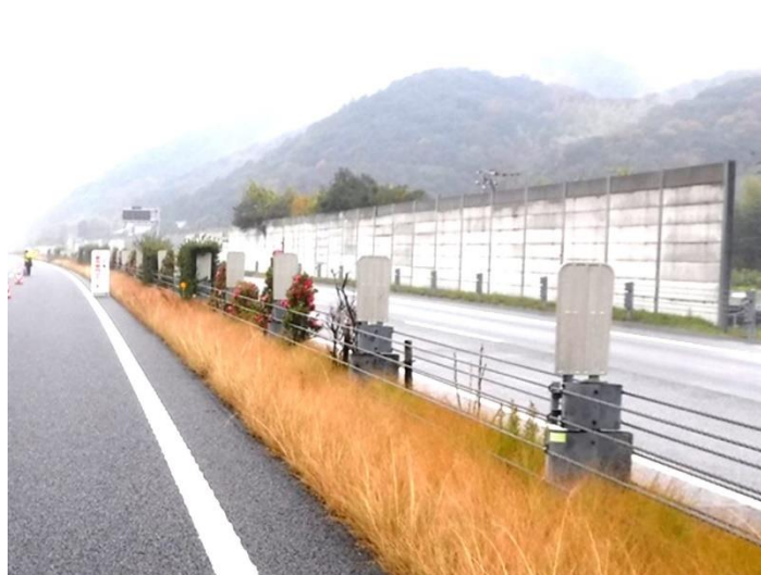
改良前（ガードケーブル）
