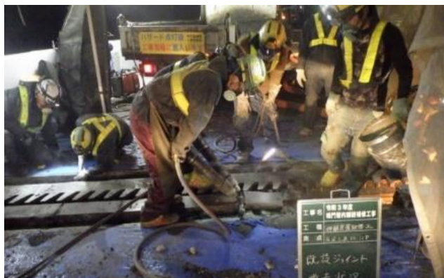
既設伸縮装置撤去状況
