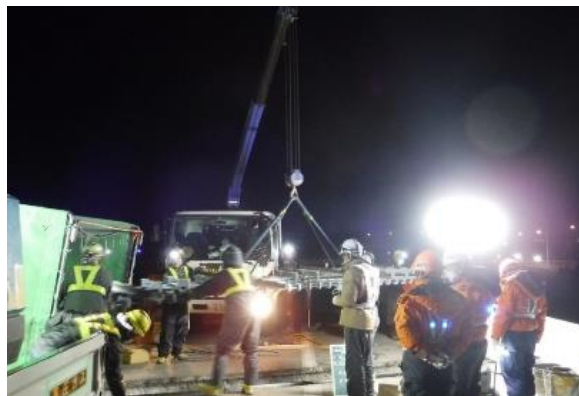
新規伸縮装置設置状況
