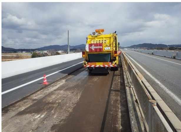
舗装切削状況
