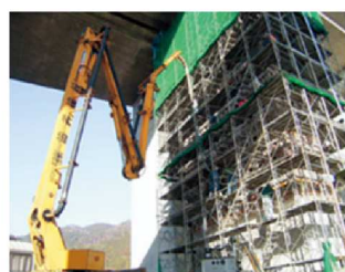
コンクリート巻き立て工法
