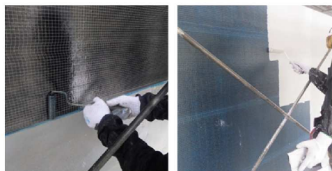
連続繊維シート工法
