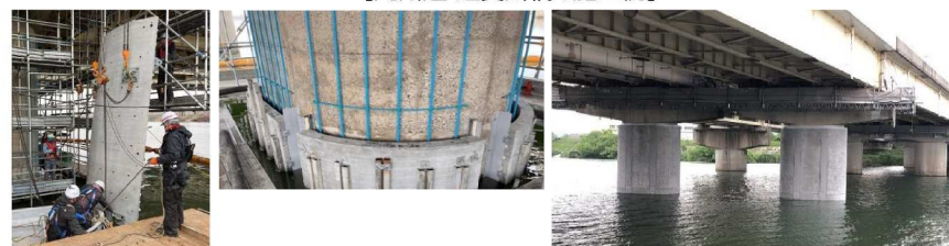
【九州道 遠賀川橋の施工例】
