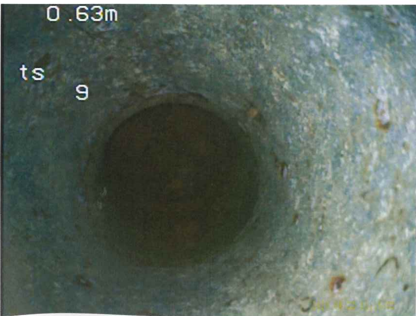
トイレ前 掃除口 立配管状況
