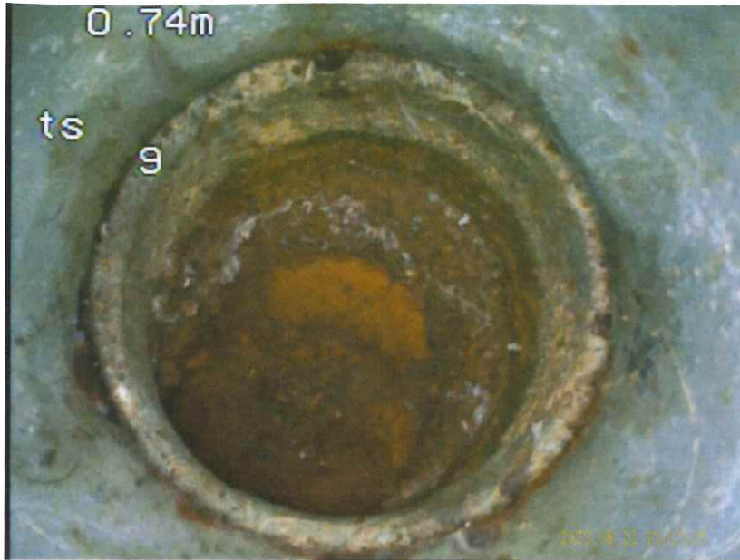
洗面所 掃除口 立配管状況
