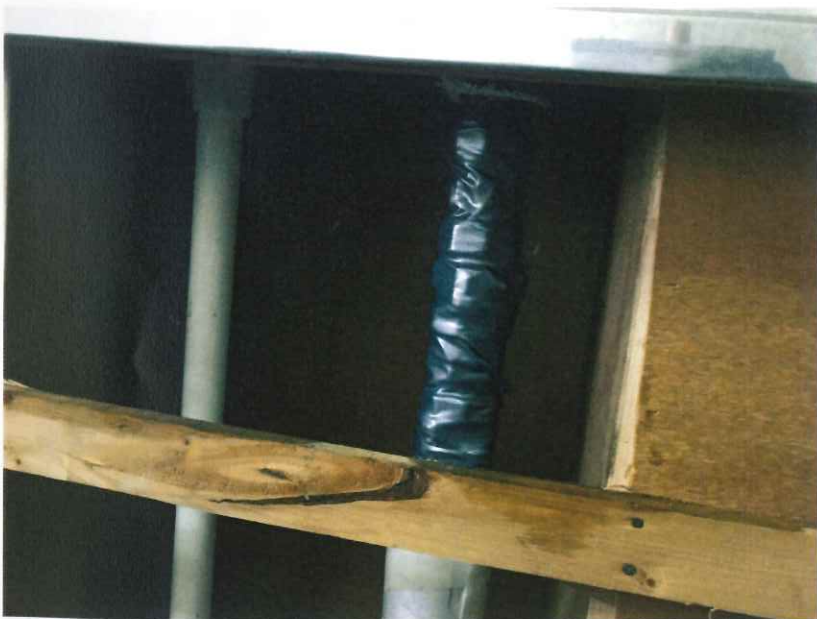
台所流し台 給水管 復旧
