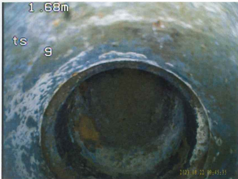
台所 掃除口 立配管状況
