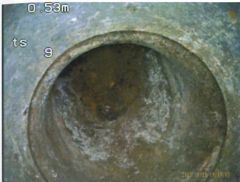
洗面所 掃除口 立配管状況
