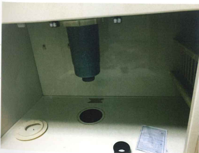
台所流し台 排水管 復旧
