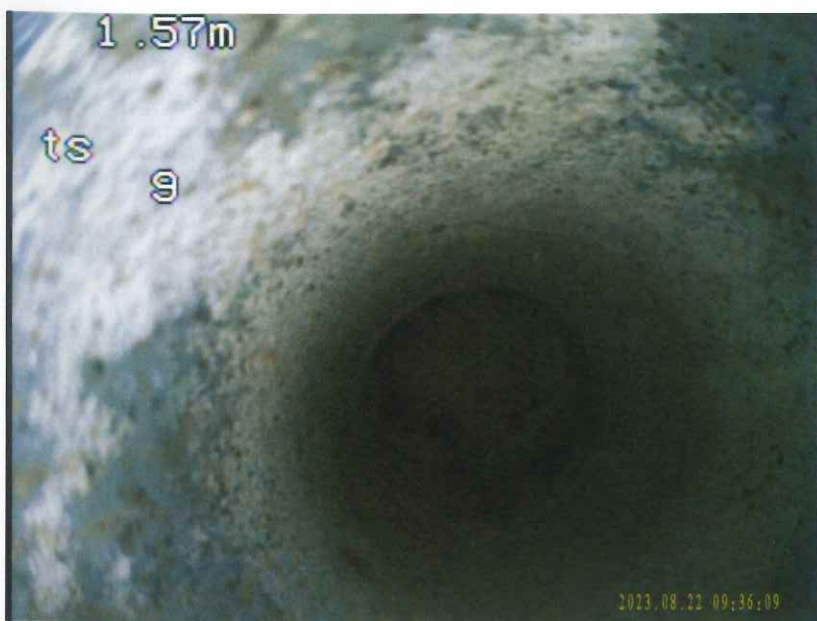
トイレ前 掃除口 立配管状況
