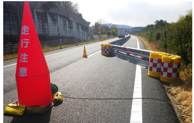
仮設防護柵の設置（過年度実施事例）
