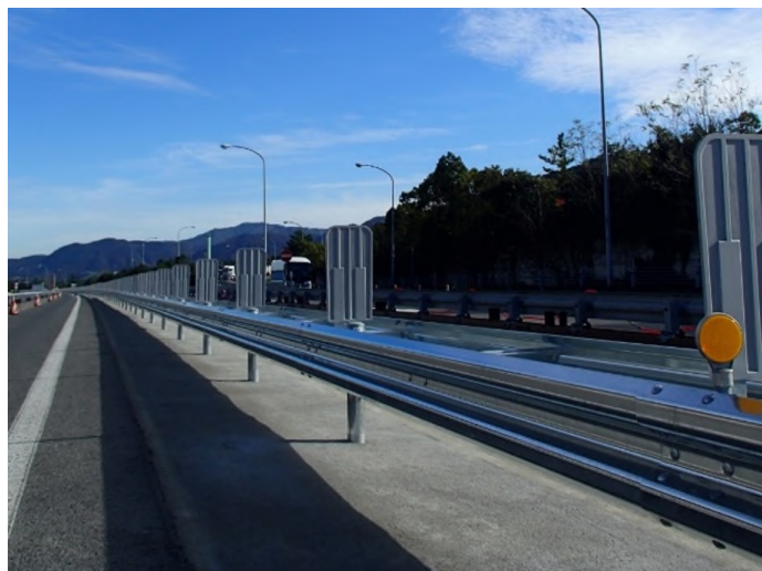
改良後（ガードレール）
