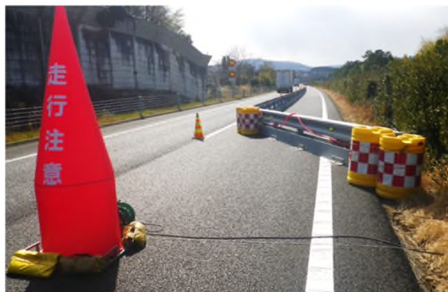
仮設防護柵の設置（過年度実施事例）
