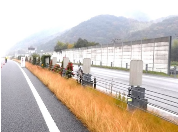
改良前（ガードケーブル）
