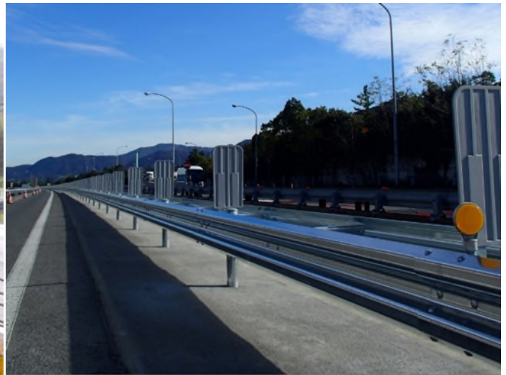
改良後（ガードレール）
