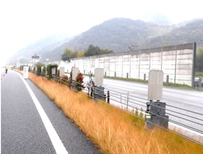
改良前（ガードケーブル）
