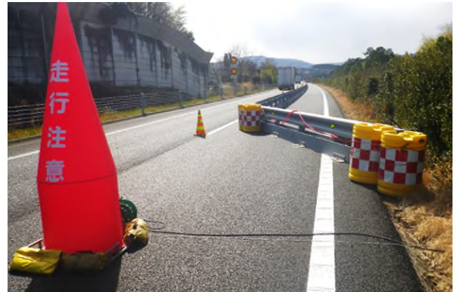
仮設防護柵の設置（過年度実施事例）
