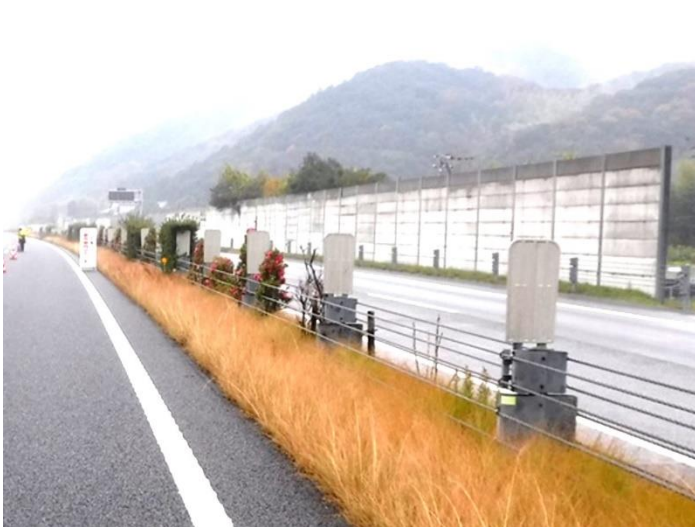
改良前（ガードケーブル）
