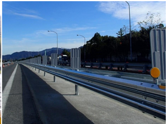
改良後（ガードレール）
