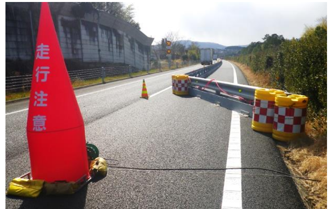
仮設防護柵の設置（過年度実施事例）
