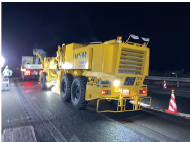
路面切削状況
