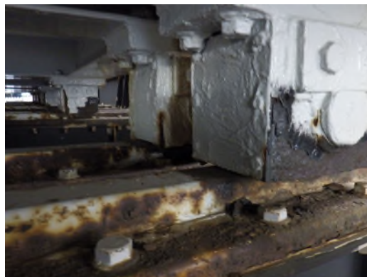
② 大型伸縮装置の腐食状況
