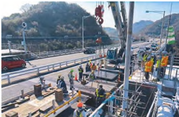
③既設大型伸縮装置撤去状況
