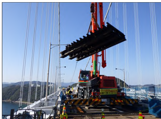
③ (旧) 大型伸縮装置撤去作業
