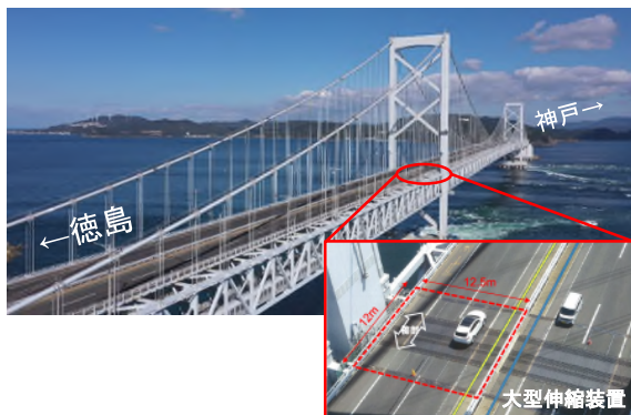
① 大型伸縮装置交換箇所
