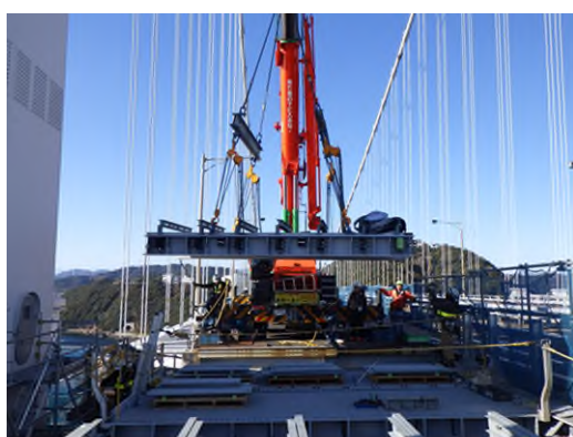
⑤ (新) 大型伸縮装置設置作業
