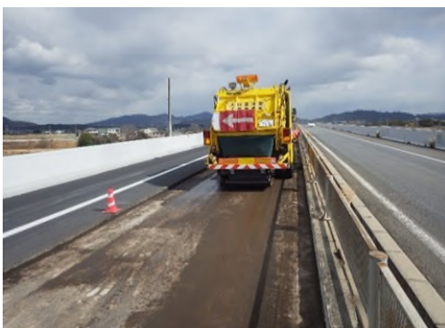
舗装切削状況(イメージ)
