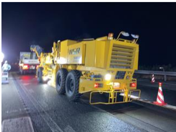
既存舗装の切削除去
