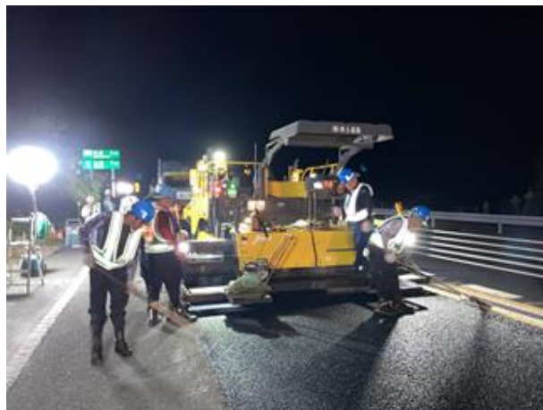
新しい舗装の敷設
