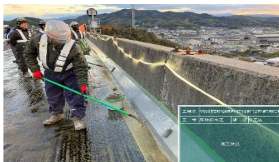
工事状況（イメージ）
