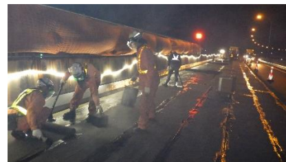
工事状況（イメージ）
