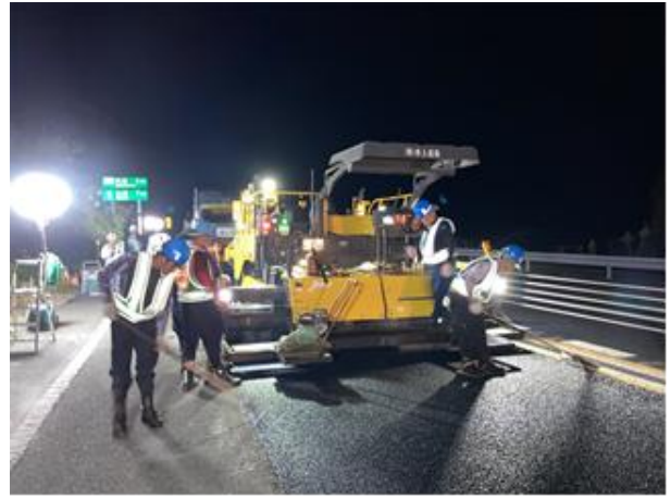
新しい舗装の敷設
