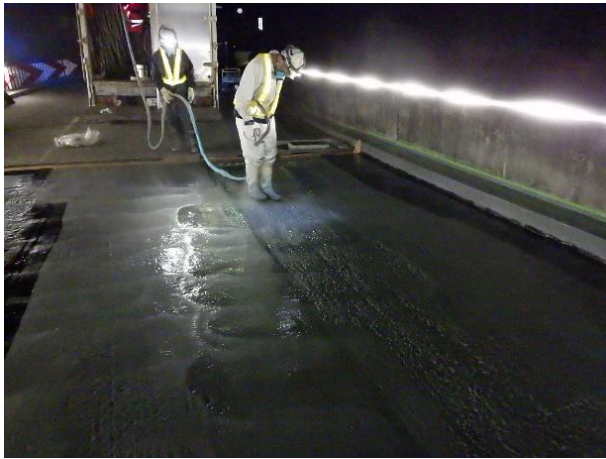
床版防水層の施工
