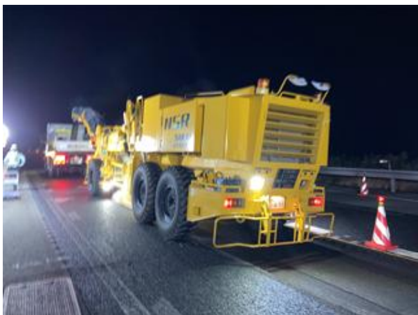
既存舗装の切削除去
