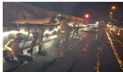
工事状況（イメージ）
