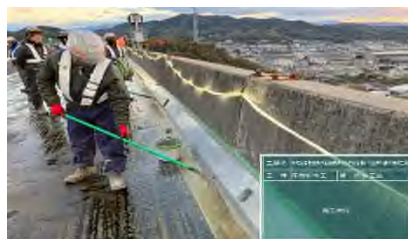
工事状況（イメージ）
